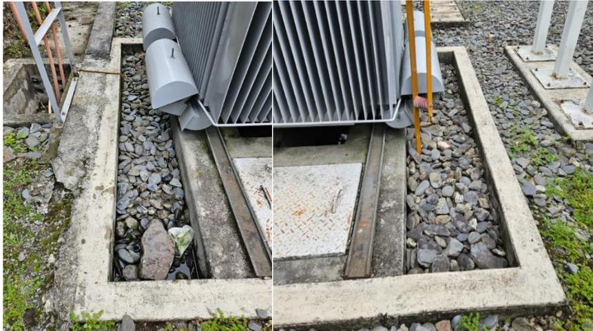
Los dos canales (largo 2.50m x ancho de 0.47m x alto 0.55m). El primero se encuentra delante del transformador y el segundo se encuentra en la parte posterior. Estos dos canales deben ser adecuados para que sea un contorno impermeabilizado de concreto pulido alrededor del transformador de una altura de 15cm x ancho 10cm.
