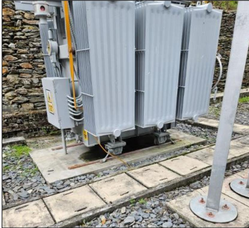
La adecuación de la fosa de acopio de aceite del volumen de la capacidad del transformador debe ser instalado por debajo del transformador y cuyos ductos de conexión debería pasar por debajo de los canales donde se encuentran los conductores de señal de protección y control.
