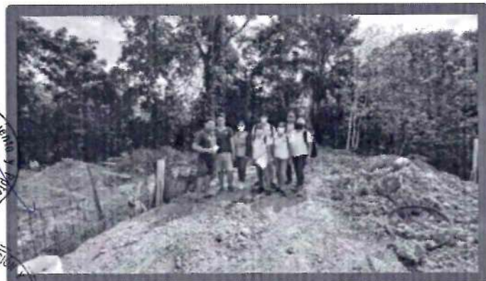
Avance de poza de sedimentación Criapacv internacional
