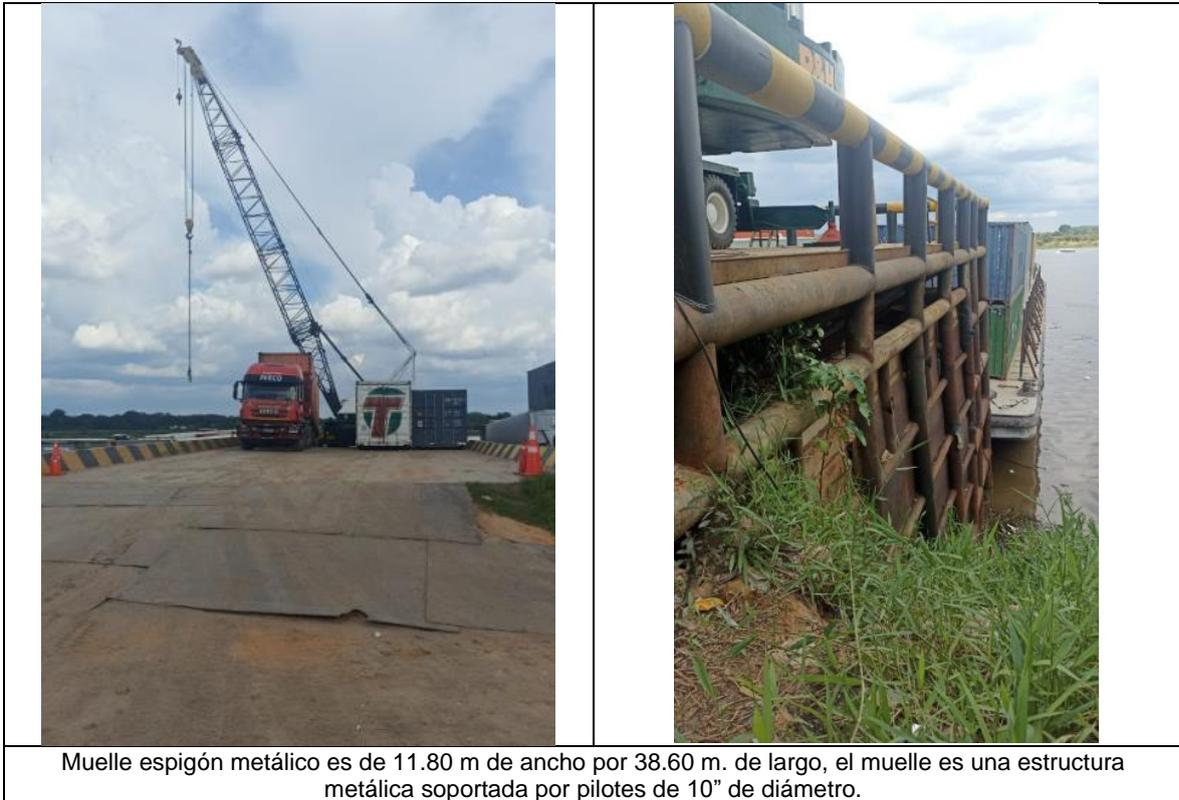
Muelle espigón metálico es de 11.80 m de ancho por 38.60 m. de largo, el muelle es una estructura metálica soportada por pilotes de 10” de diámetro.
