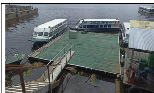
Embarcadero flotante de madera pintada de 9.15 m x 8 m para el embarque y desembarque pasajeros y avituallando (víveres, balones de gas, combustible) la misma que se encuentra en buenas condiciones
