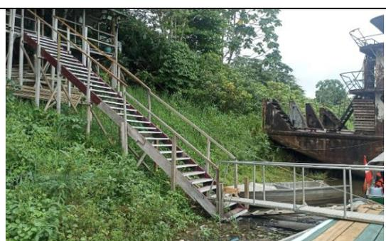
Escalera de acceso de madera y rampa de aluminio al Embarcadero flotante, la misma que se encuentra en buenas condiciones.
