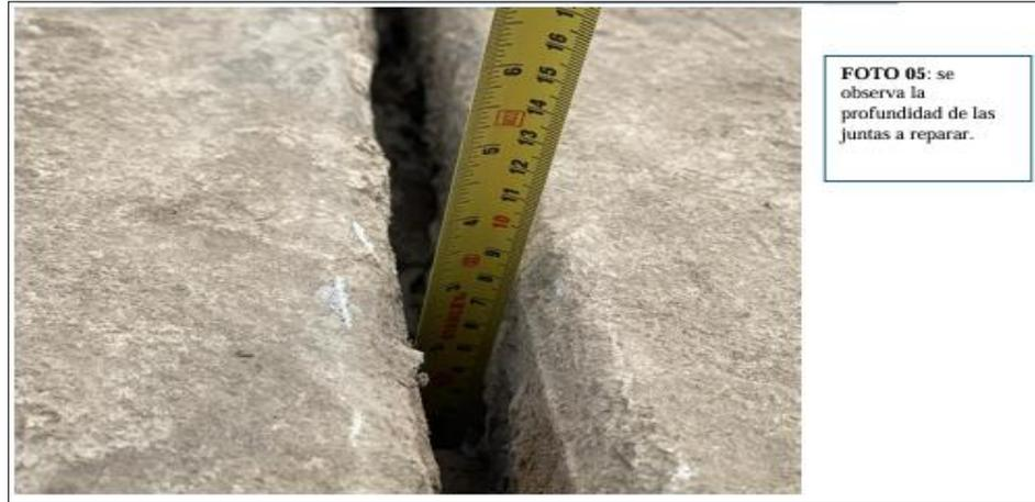
**FOTO 05:** se observa la profundidad de las juntas a reparar.
