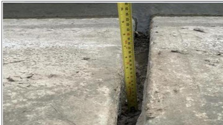
**FOTO 03:** se observa la profundidad de las juntas a reparar.
