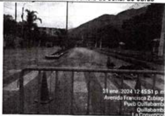
Ilustración N°8 – Usencia de señal de obras
