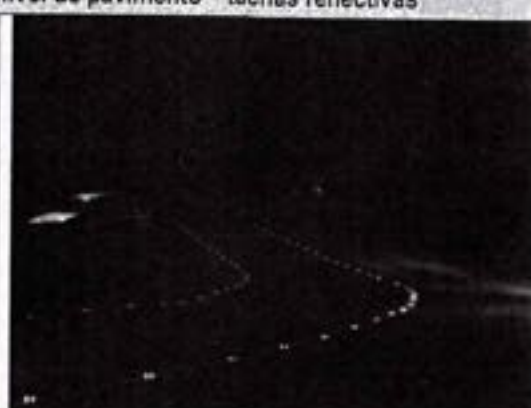
Ilustración N° 5.6.4.- Delineadores a nivel de pavimento – tachas reflectivas
