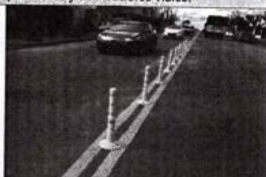
Ilustración N° 5.6.3.A.- Marcas en el pavimento y delineadores viales.
