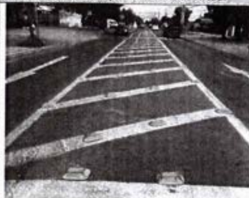
Ilustración N° 5.6.3C.- Demarcación de flechas direccionales e separador central virtual
