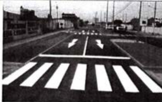
Ilustración N° 5.6.3.B.- Demarcación de líneas peatonales y línea continua.
