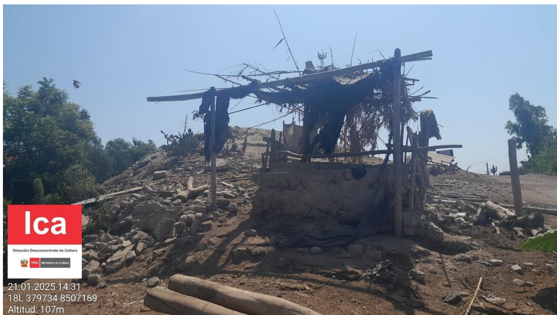
Imagen 03: vista panorámico de corral a base de cemento y techos de palos costal de polietileno.
