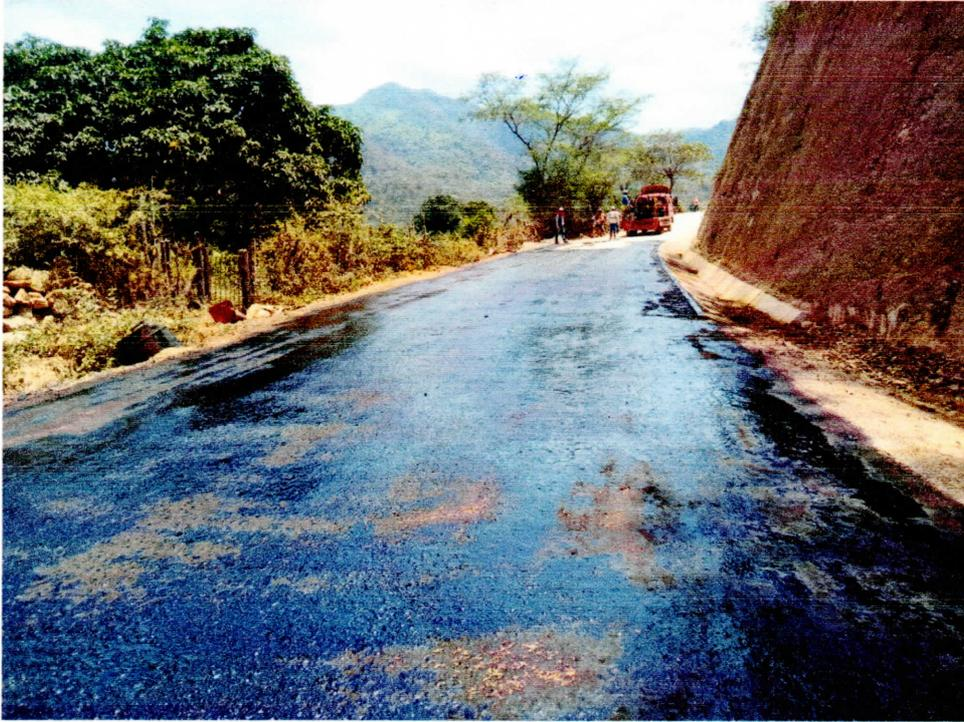
**Fotografia N ° 01:** Colocacion de Imprimacion Asfaltica MC-30 con RC-250 en tramo prueba.
