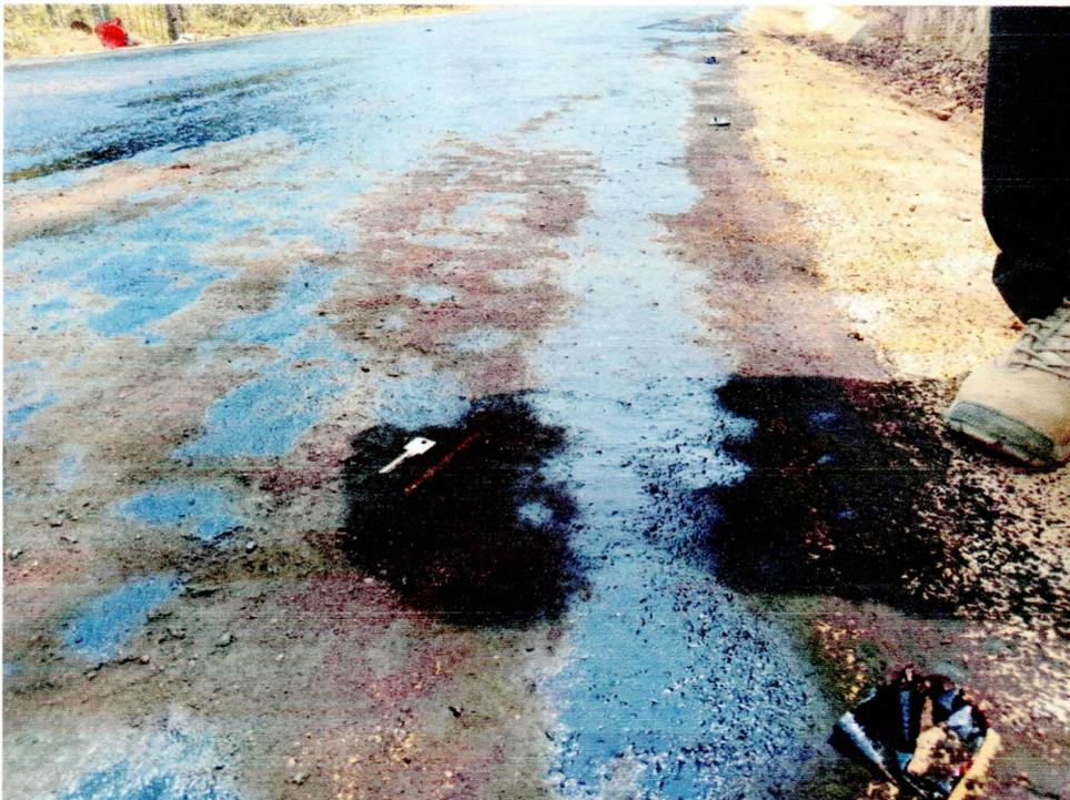
**Fotografia N ° 02:** Imprimacion Asfaltica MC-30 con RC-250 cumple con la penetración solicitada en el expediente técnico de obra aprobado.
