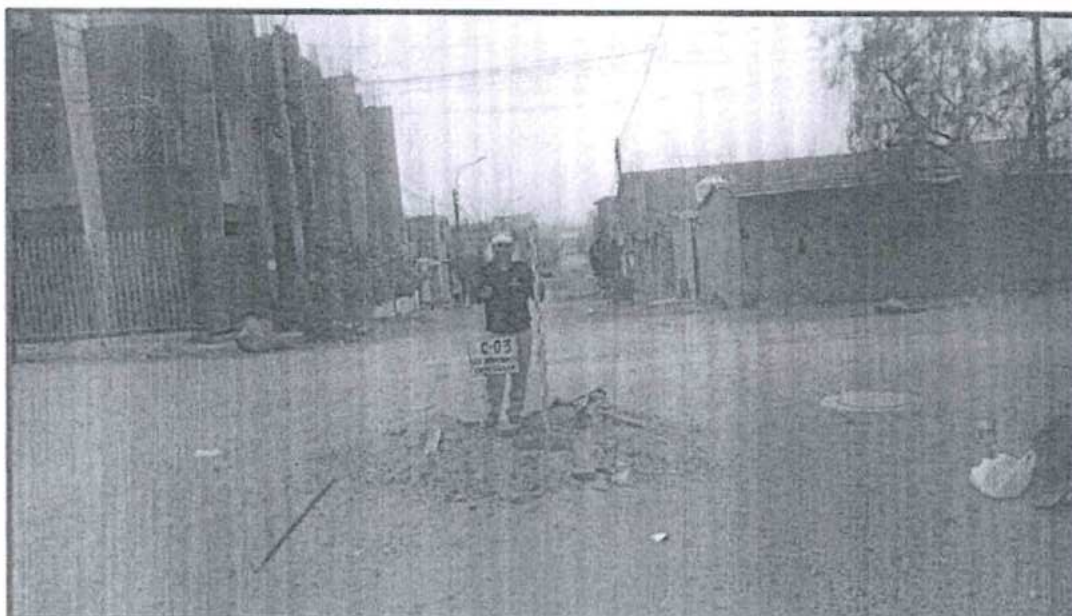
Foto N° 09.- Vista de la ubicación de excavación de la calicata C-3 terminada, excavada hasta 1.50m de profundidad.
