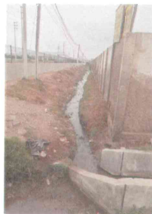
Mantenimiento y limpieza del canal Camal, ubicado en la Zona de Reglamentación Especial de Pantanos de Villa
