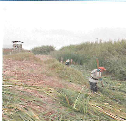
Mantenimiento y limpieza del canal Defensores del Morro
