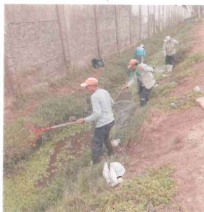
Mantenimiento y limpieza del canal Camal, ubicado en la Zona de Reglamentación Especial de Pantanos de Villa
