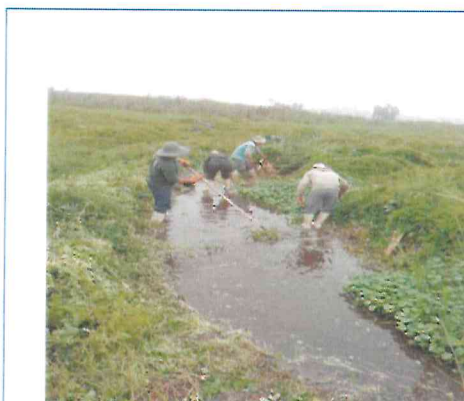
Mantenimiento y limpieza de la laguna Marvilla
