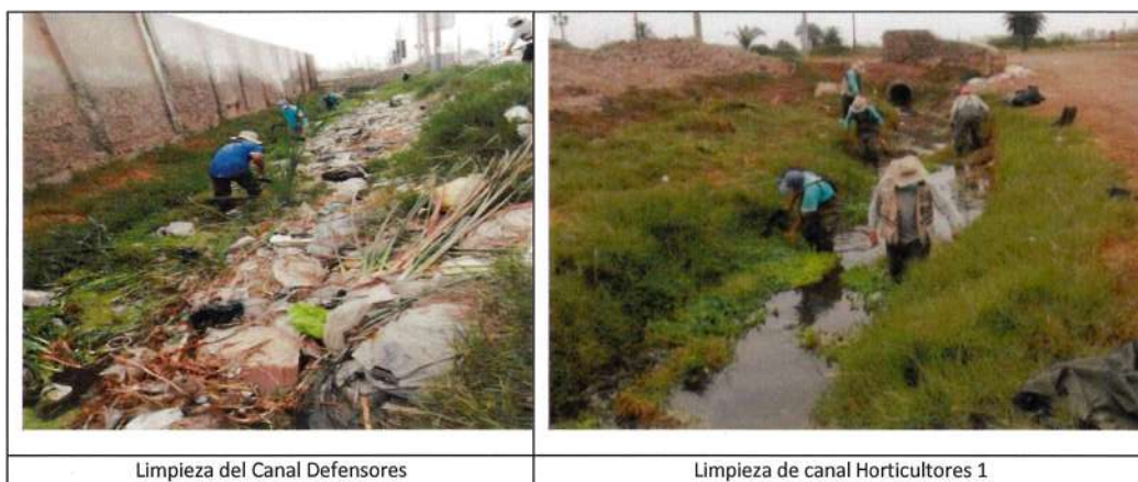
Limpieza del Canal Defensores
