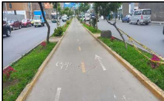
Recuperación de la Berma central Av. Izaguirre
