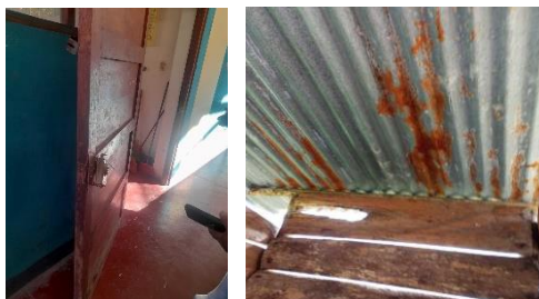
Panel fotográfico del estado del LE
