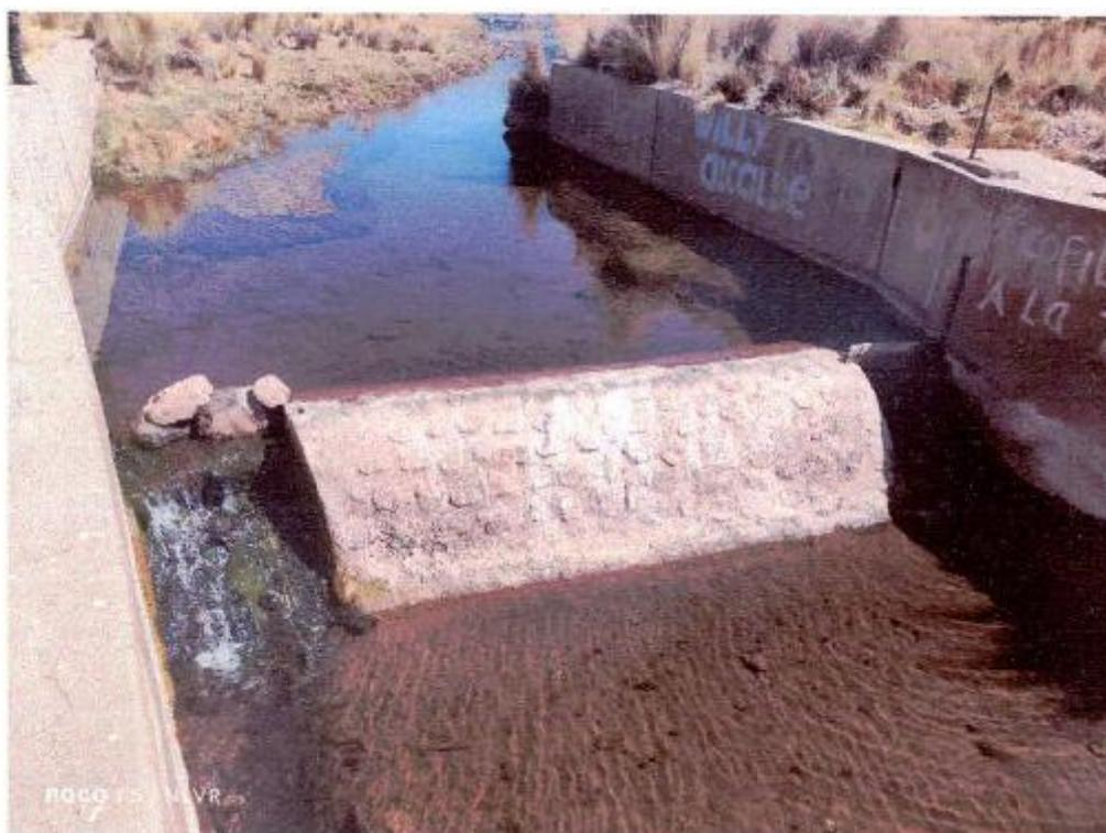
*Foto: imagen de la bocatoma tipo barraje del canal de riego - Acoyo Frontis*
