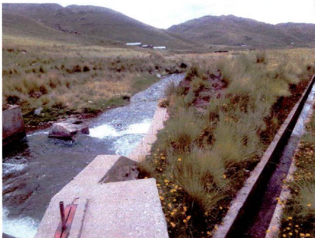
Foto 03: Estructura actual de captación bocatoma aguas abajo.
