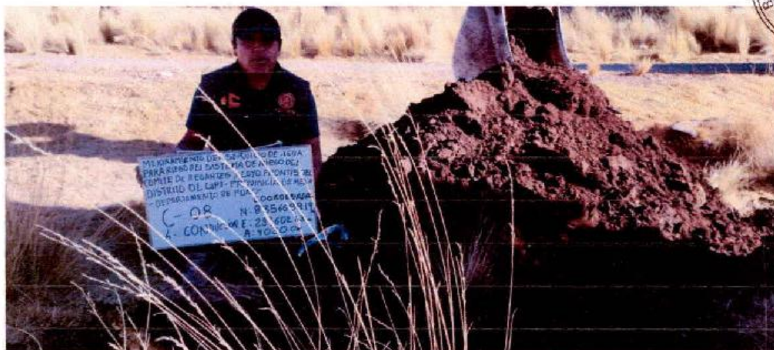
Foto N° 13- vista de la calicata 08- línea de conducción.
