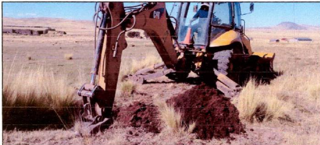
Foto N° 05- inicio de la conformación de las calicatas con maquinaria.
