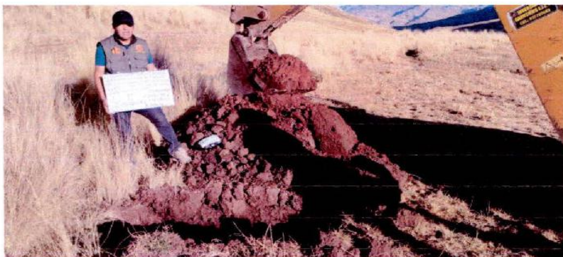
Foto N° 15- vista de la calicata 10- línea de conducción.
