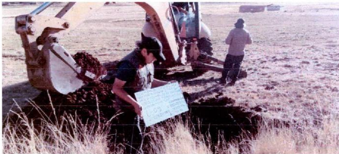
Foto N° 14 - vista de la calicata 09- línea de conducción.
