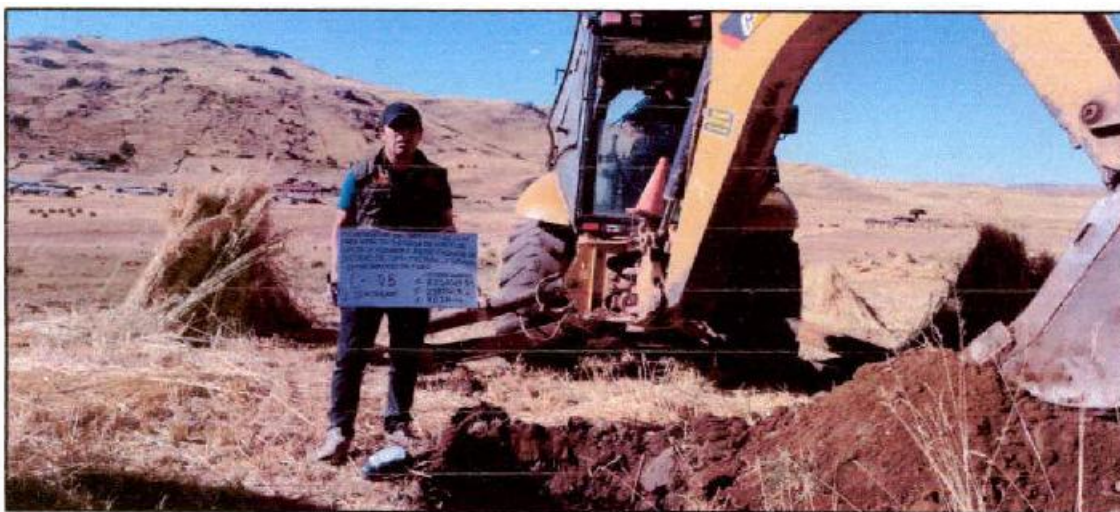
Foto N° 10 - vista de la calicata 05- línea de conducción
