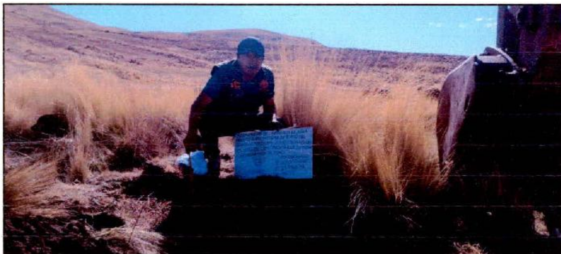
Foto N° 12 - vista de la calicata 07- línea de conducción.
