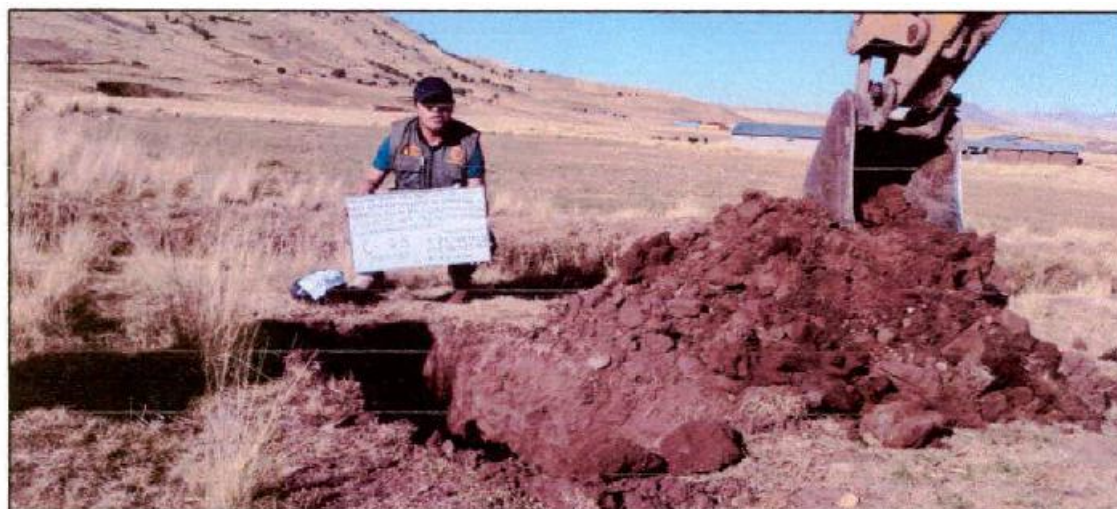
Foto N° 08- vista de la calicata 03- línea de conducción.
