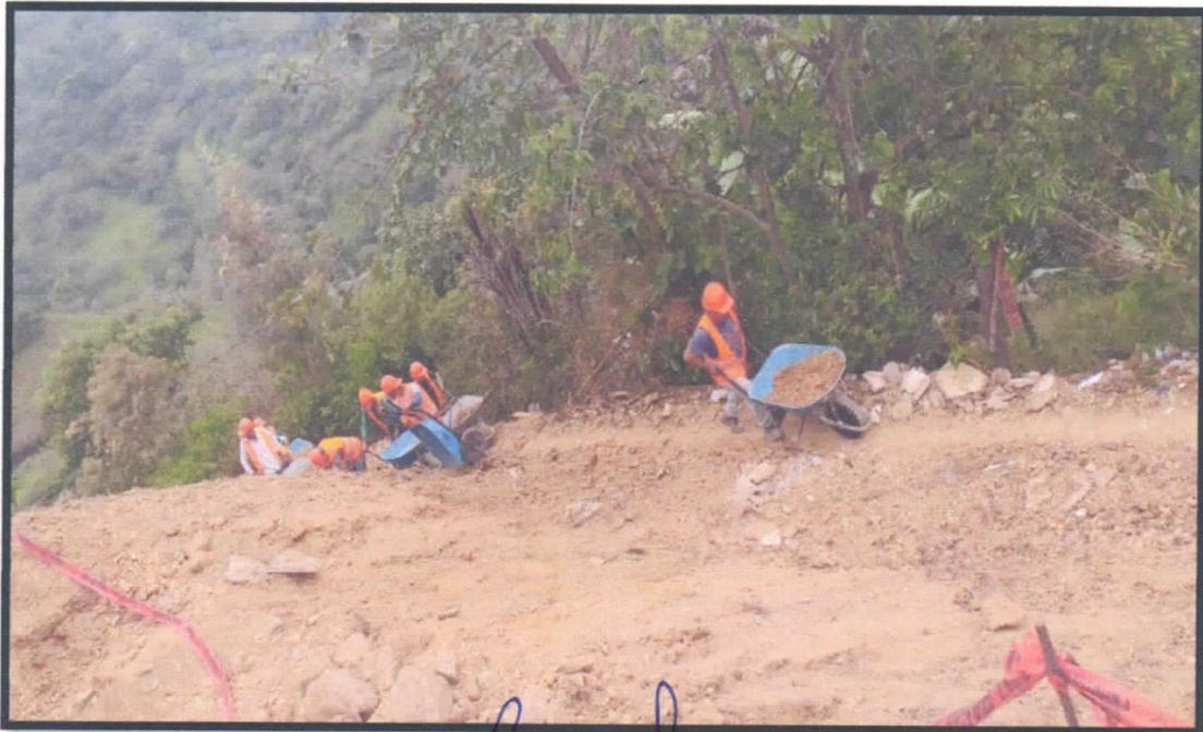
FOTOGRAFIA 01: IACARREO DE MATERIAL PROPIO PARA RELLENO Y COMPACTACIÓN
