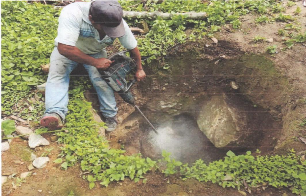
Imagen 05: perforación de roca para hacer voladura
