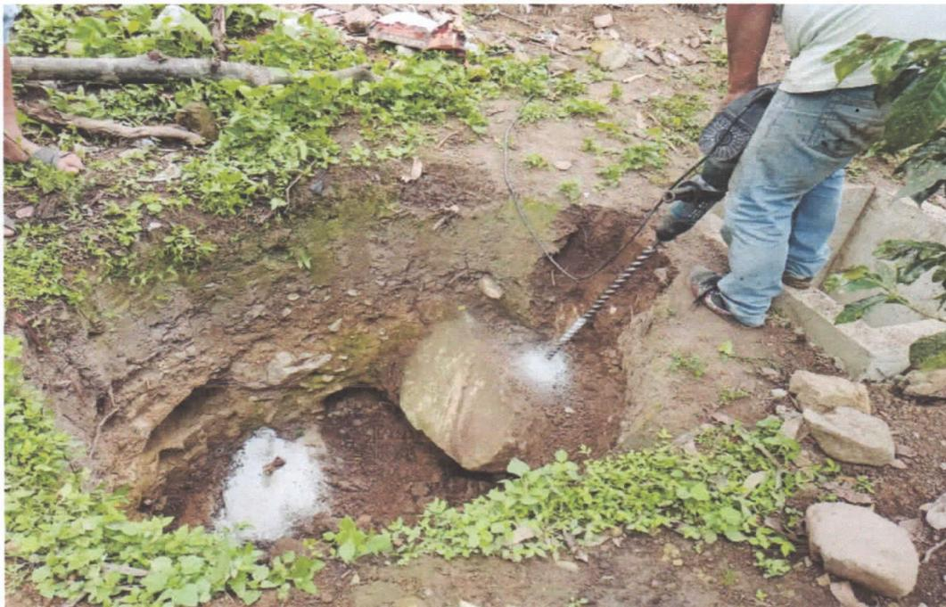
Imagen 06: perforación de roca para hacer voladura
