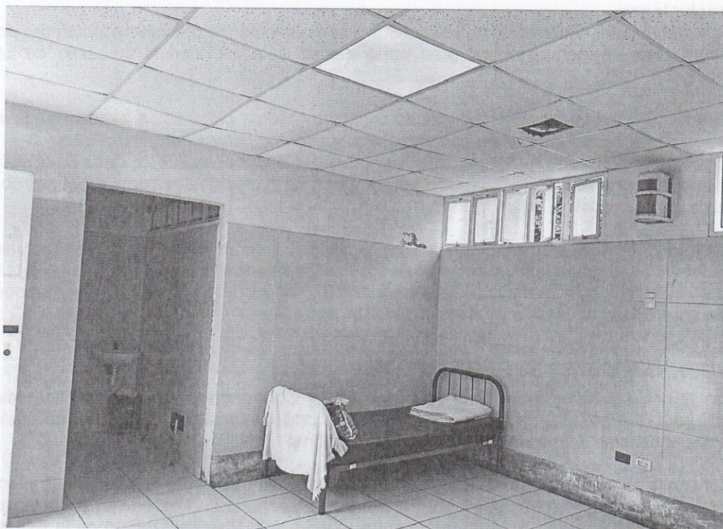
Figura 02: Interior del área destinada para el aislamiento invertido. Patio de esparcimiento de UCEG. Utilizada inicialmente para la atención de pacientes COVID-19.
