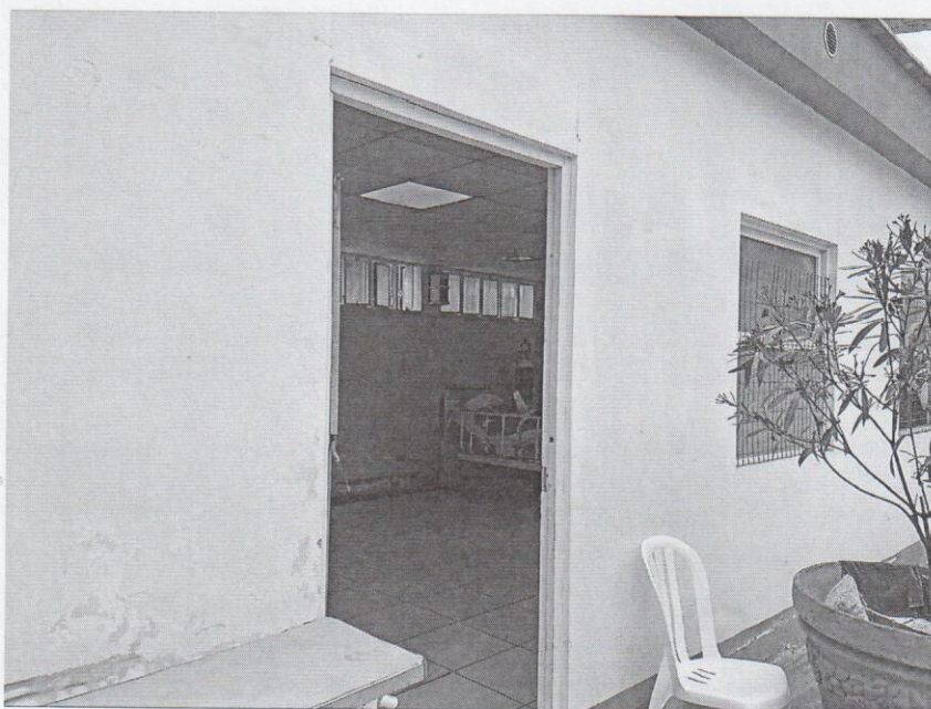
Figura 01. Puerta exterior del área destinada para el aislamiento invertido. Patio de esparcimiento de UCEG. Utilizada inicialmente para la atención de pacientes COVID-19.
