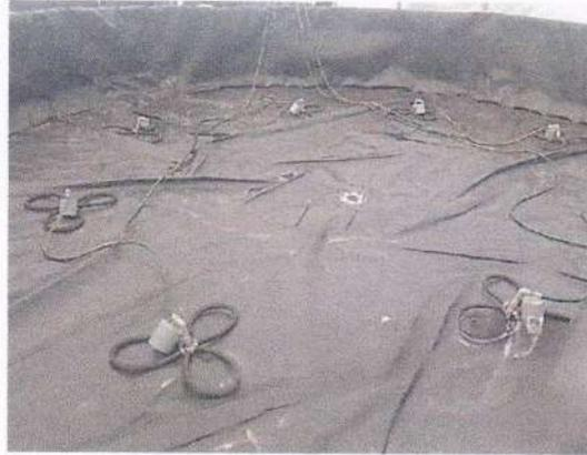
Fig. 01: Instalación del sistema de aireación
