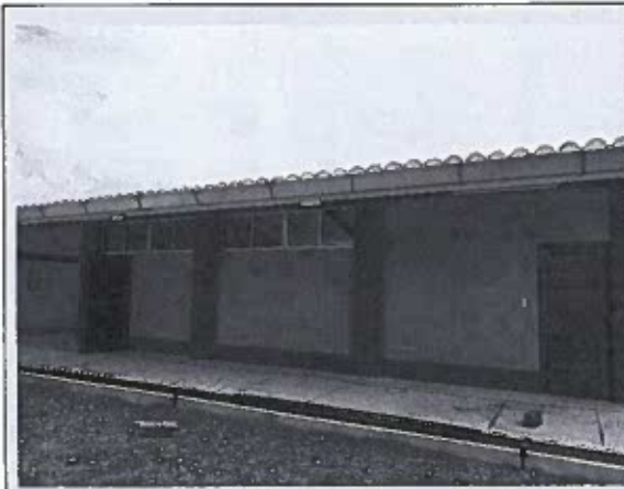
Imagen 09: Vista del modulo 01
