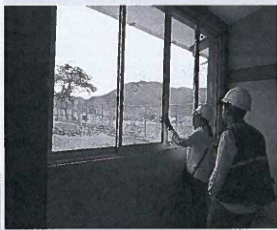
Imagen 02: Verificación de las ventanas en compañía del supervisor
