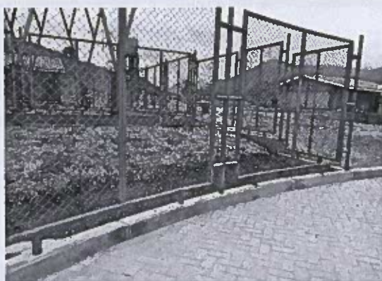
Imagen 05: Vista de cerco de mallas, apoyos con presencia de óxido.
