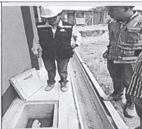
Imagen 02: Vista de las cajas de válvulas de agua
