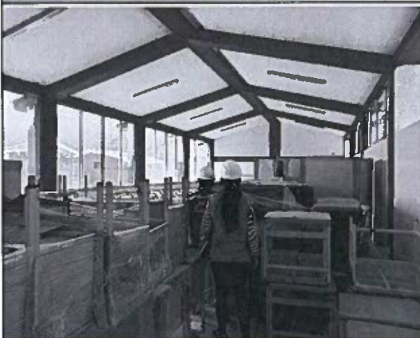
Imagen 05: Vista de cerco de mallas, apoyos con presencia de óxido.
