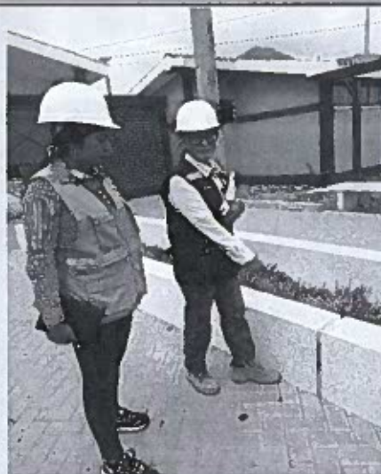
Imagen 10: Se identifica observaciones en las juntas de dilatación, relleno incompleto
