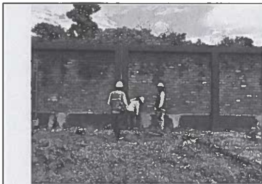
Imagen 05: Verificando levantamiento de observaciones de cerco
