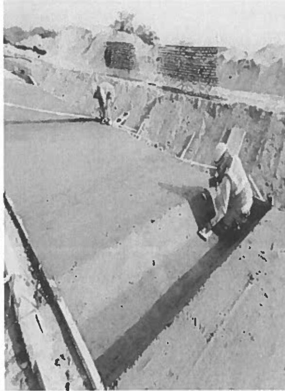
**Fotografía n.º 14: Trabajos de conformación de sub base para baden n.º 37 PI-115**
