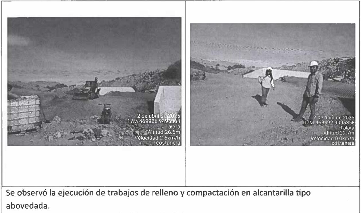
Se observó la ejecución de trabajos de relleno y compactación en alcantarilla tipo abovedada.
