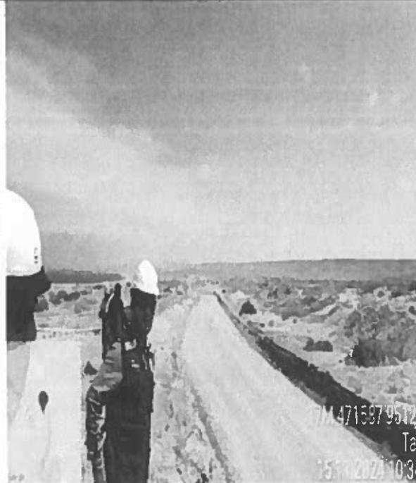
**Fotografía n.º 8 :** Trabajos de conformación de sub base Km 31+340 hasta Km 32+500 aproximadamente. PI-100
