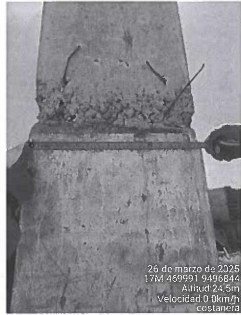
Se visualiza segregación de concreto en alero de salida de alcantarilla.
