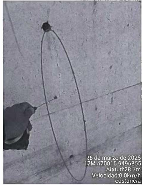
Se observó fisuras en alero de salida de alcantarilla.
