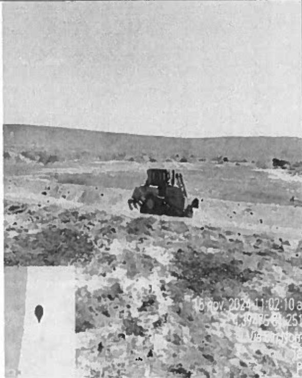
**Fotografía n.º 10:** Corte de terreno hasta nivel de fundación, badén n.º 14 progresiva Km 37+050, PI-100
