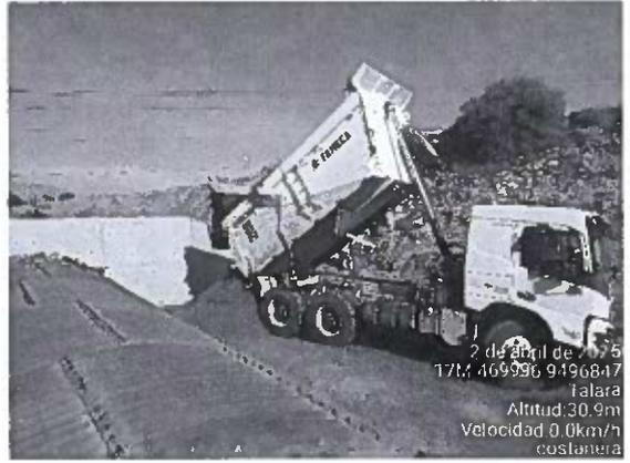
Se observó la ejecución de trabajos de relleno y compactación en alcantarilla tipo abovedada. Los obreros no cuentan con EPP completos ( lentes y botas de seguridad, guantes).
