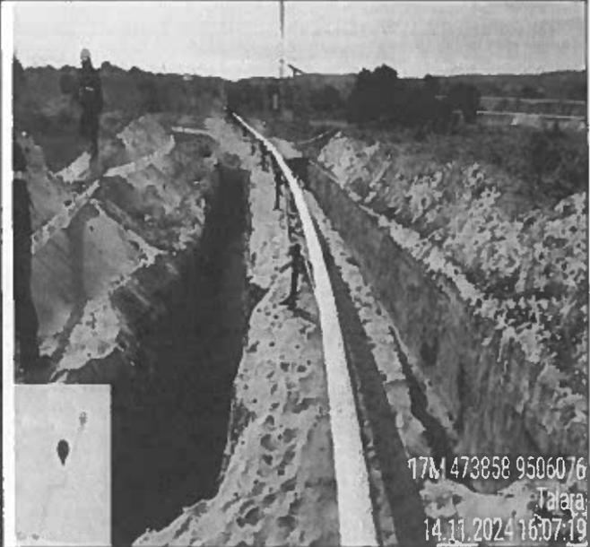
**Fotografía n.º 17: Corte y excavación de terreno a nivel de terreno de fundación, baden n.º 40 PI-115**
