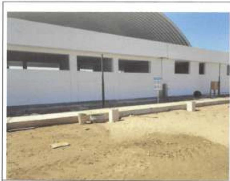
Se verifico el levantamiento de observaciones correspondiente a las veredas, las cuales no presentan fisuras ni cangrejeras.
