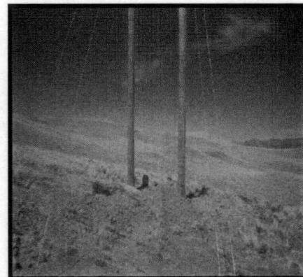
Foto 10: Poste tipo EH - Biposte, con 02 cables de guarda de 5/8", observándose también las zanjas de puesta a tierra con retenidas. Se observa suelos disturbados sin rehabilitar.
