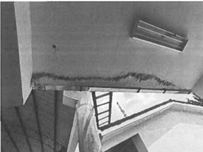
**Descripción:** Presencia de infiltración de agua en cielo raso
