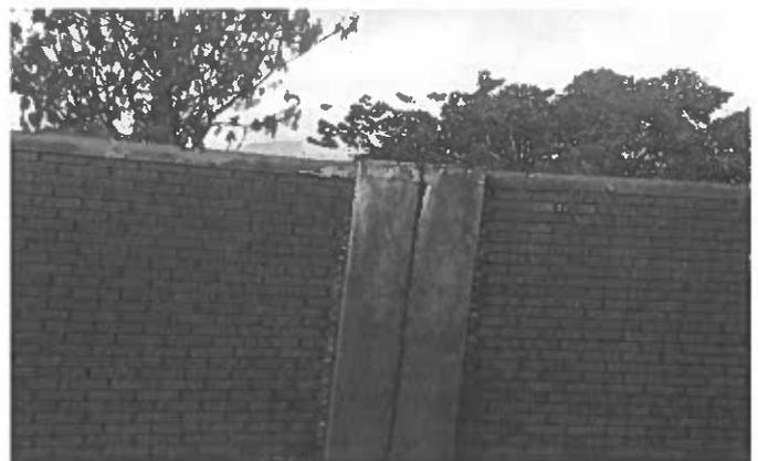
**Descripción:** Se observa la presencia de fisuras en la columna del cerco perimétrico
