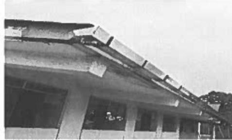
**DESCRIPCIÓN:** Se observa la instalación de la canaleta para evacuación del agua del techo en el pabellón de secundario.
