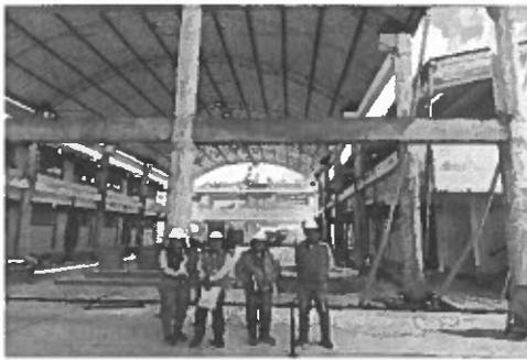
**DESCRIPCIÓN:** Se observa que falta el pintado de vigas y columnas.
