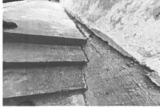
**DESCRIPCIÓN:** Se observa la presencia de fisuras en la escalera de la vereda
