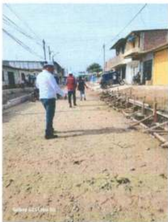
En la vista fotográfica se observa a la consejera regional junto a su equipo de profesionales realizando un recorrido de la obra y se verifica la ejecución de la partida encofrado de sardineles.
