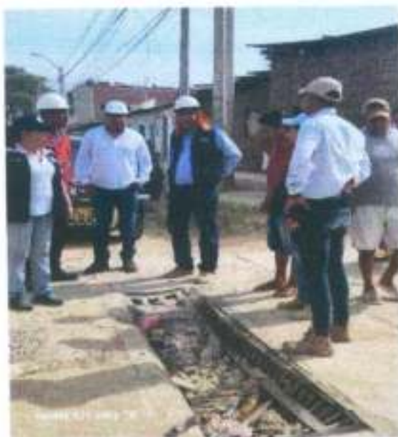
Vista fotográfica: colmatación de alcantarilla
