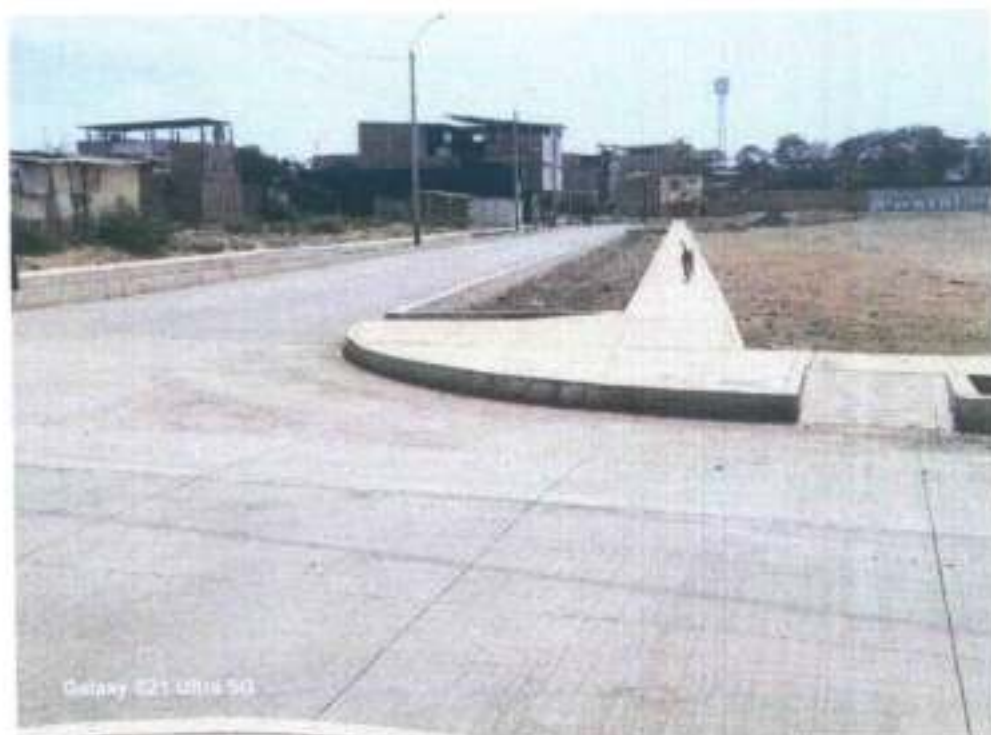
En la vista fotográfica se observa calles total mente pavimentadas con sardineles y rampas de acceso.
