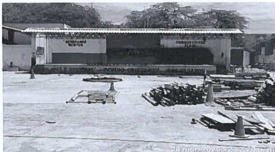
Reconstrucción del Colegio Principal Divino Cristo Rey
