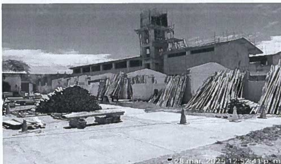
Trabajos de reconstrucción del Local Educativo
