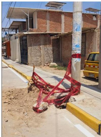
Imagen N° 08- SE OBSERVA QUE EL CONTRATISTA AL REALIZAR LOS TRABAJOS DE VEREDAS DE CONCRETOS HA DEJADO ESQUINA EN MAL, COMO ES EN EL CASO DE LA CASA UBICADA EN LA CALLE LAS BEGONIAS INTERSECCIÓN LOS ALMENDROS
