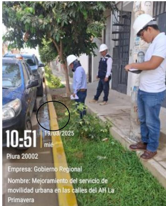
e) Emboquillados: Verificación de la pendiente de las rasantes del emboquillado EB-01, se advierte que tienen poca pendiente para evacuación de aguas pluviales.
