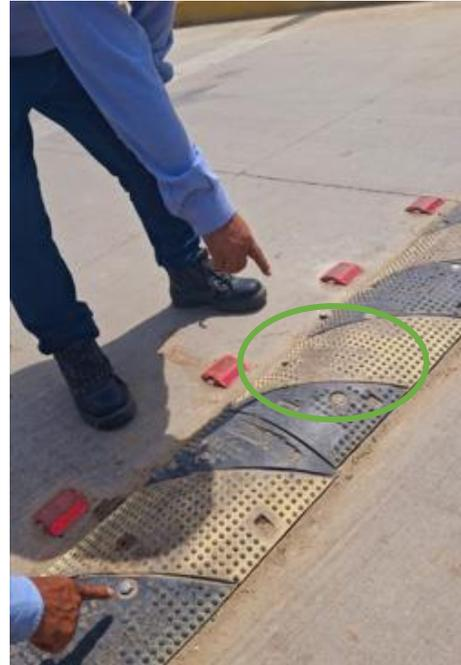
Imagen N° 16 - Calle los Claveles, se observa desgaste prematuro de los reductores de material de caucho reciclado, a pesar de ser nuevos e instalados recientemente.
