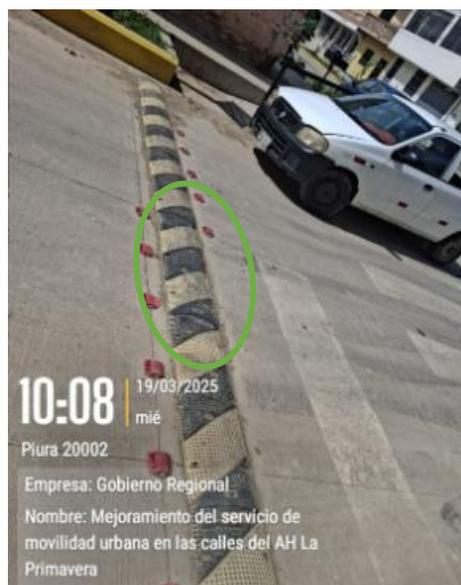
Imagen N° 17 – Desgaste prematuro de los reductores de material de caucho
