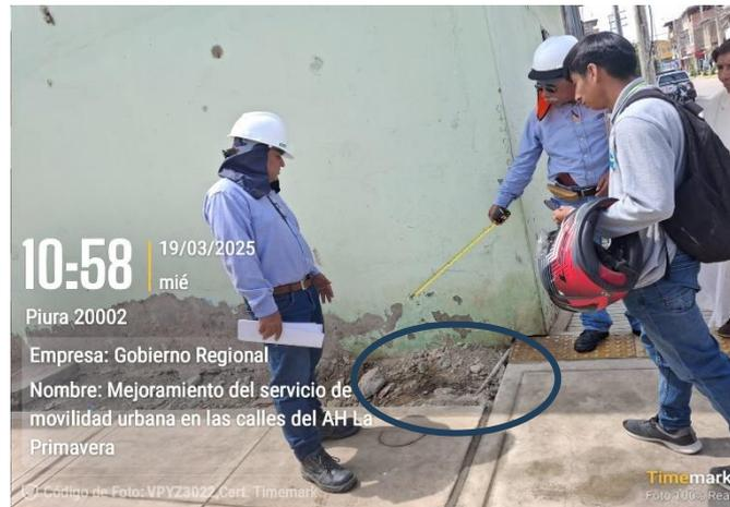
Imagen N° 09- REDUCTOR DE VELOCIDAD DE DEFICIENTE CALIDAD, UBICADO EN CALLE LOS CLAVELES
