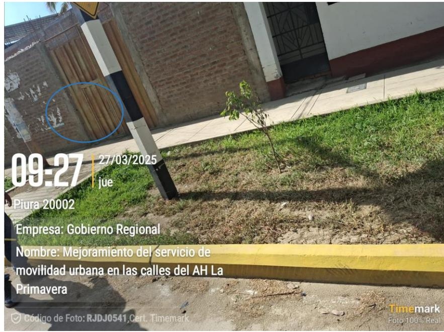
Imagen N° 38 - Continúa la presencia de fisura en soporte de señalética
