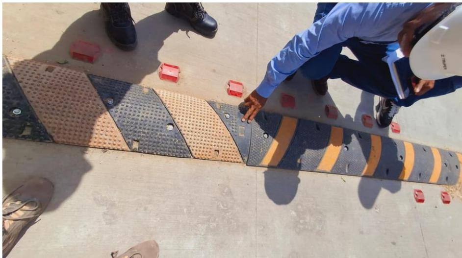
Imagen N° 15- RAMPA NO CUMPLE CON PENDIENTE MINIMA, CONFORME SE OBSERVA EN LA CALLE LAS BEGONIAS
