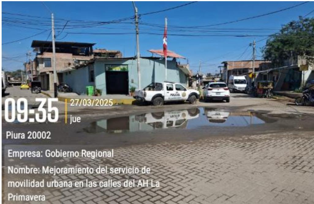
Imagen N° 17 – EMPOZAMIENTO DE AGUA DE LLUVIAS, DEBIDO A DESNIVELES ENTRE PAVIMENTO NUEVO Y PAVIMENTO EXISTENTE – INTERSECCIÓN CALLE LAS BEGONIAS CON CALLE LOS COCOS
