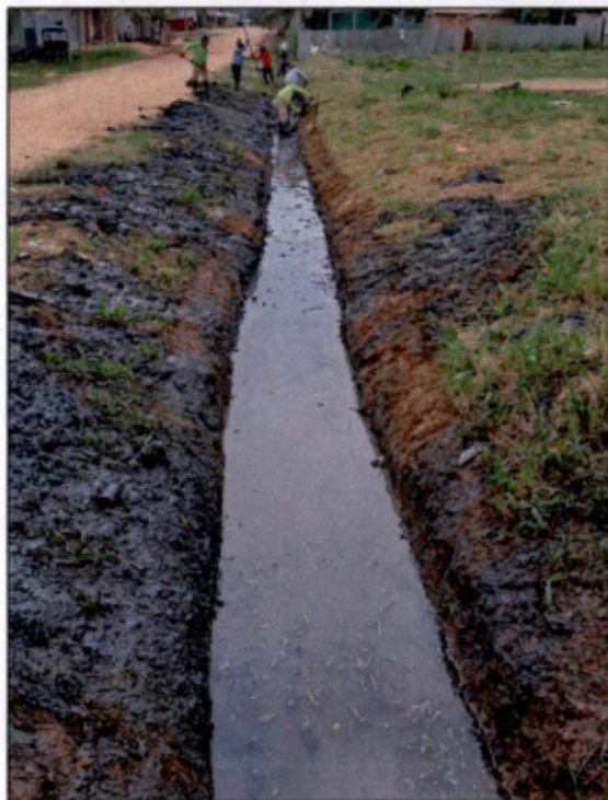
Imagen N° 07: Perfilación de los laterales del caño natural y además de la profundidad para evitar rebasamiento del agua.
