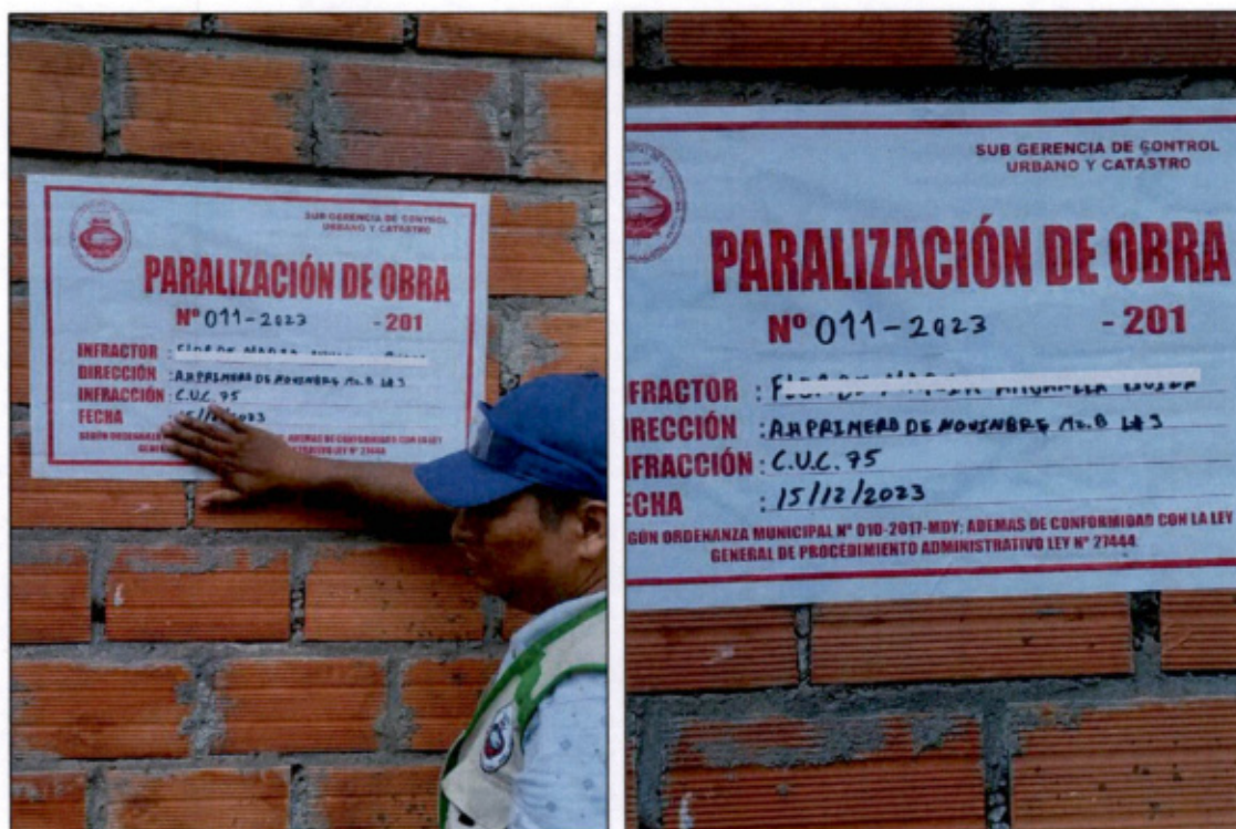
Imagen 09: Caso en donde se procede con una sanción y paralización de obra por desvío de caño natural.
