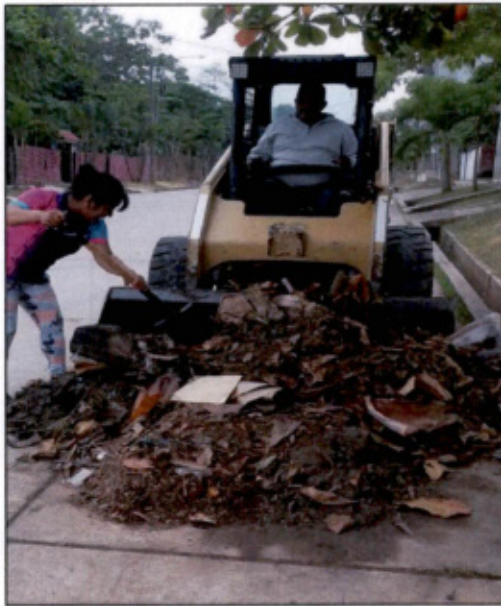
Imagen N°12: Recojo de residuos provenientes de la limpieza de zanjias pluviales, con el apoyo de un minicargador.
