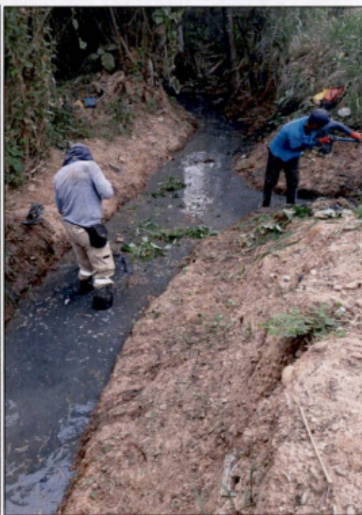
Imagen N° 07: Perfilación de los laterales del caño natural y además de la profundidad para evitar rebasamiento del agua.
