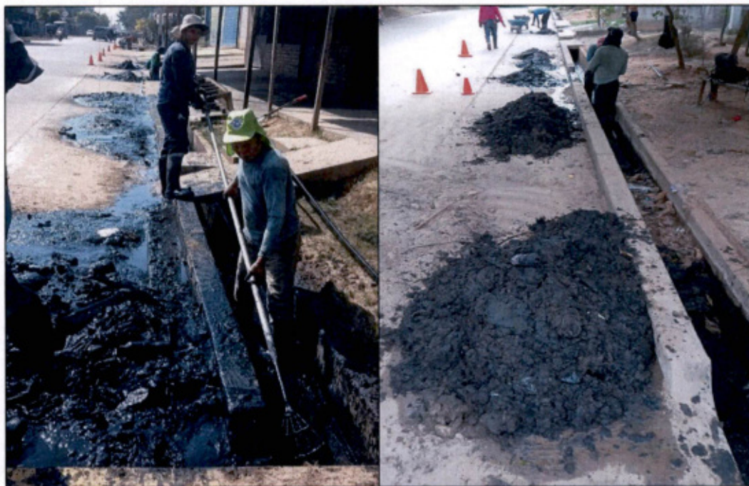
Imagen 01: Como primer paso se procede a retirar residuos y tierra que se encuentre dentro de la zanja pluvial/cuneta
