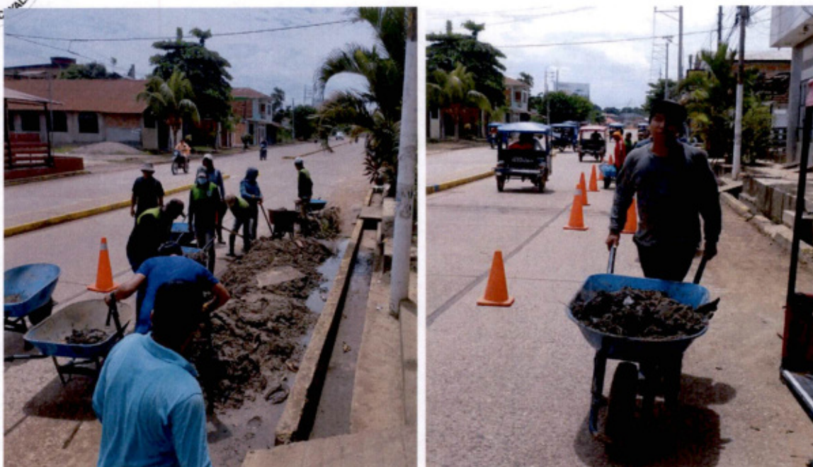
Imagen N 014: Recojo de residuos generados por la limpieza de zanjas pluviales utilizando carretillas y palas
