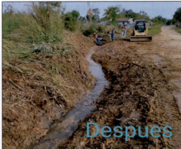
Imagen N° 10: Perfilado de zanjas con palas mediante excavación con palas los bordes y
