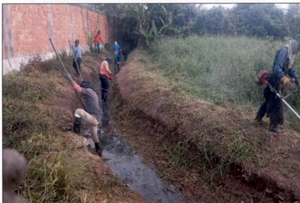
Imagen N06: Limpieza preventiva de caños naturales para evitar futuros estancamientos por presencia de residuos sólidos.
