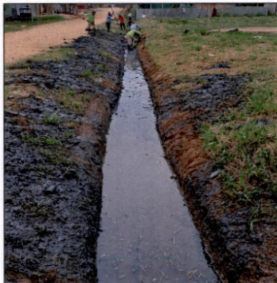
Imagen N° 11: Perfilado de zanjas pluviales y/o caños naturales, esto permite la mejor conducción del agua, evitando que el agua rebase.
