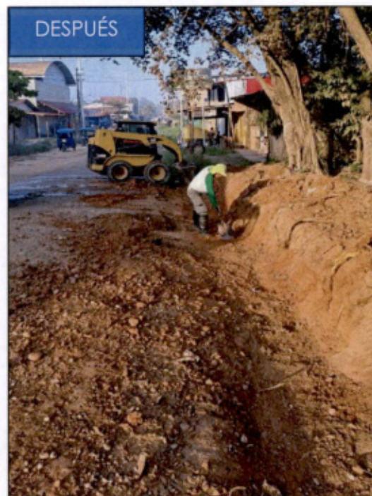
Imagen N° 08: Caso de Reapertura de zanja pluvial, con apoyo de un minicargador y el apoyo de un trabajador para evitar cortes de tuberías.
