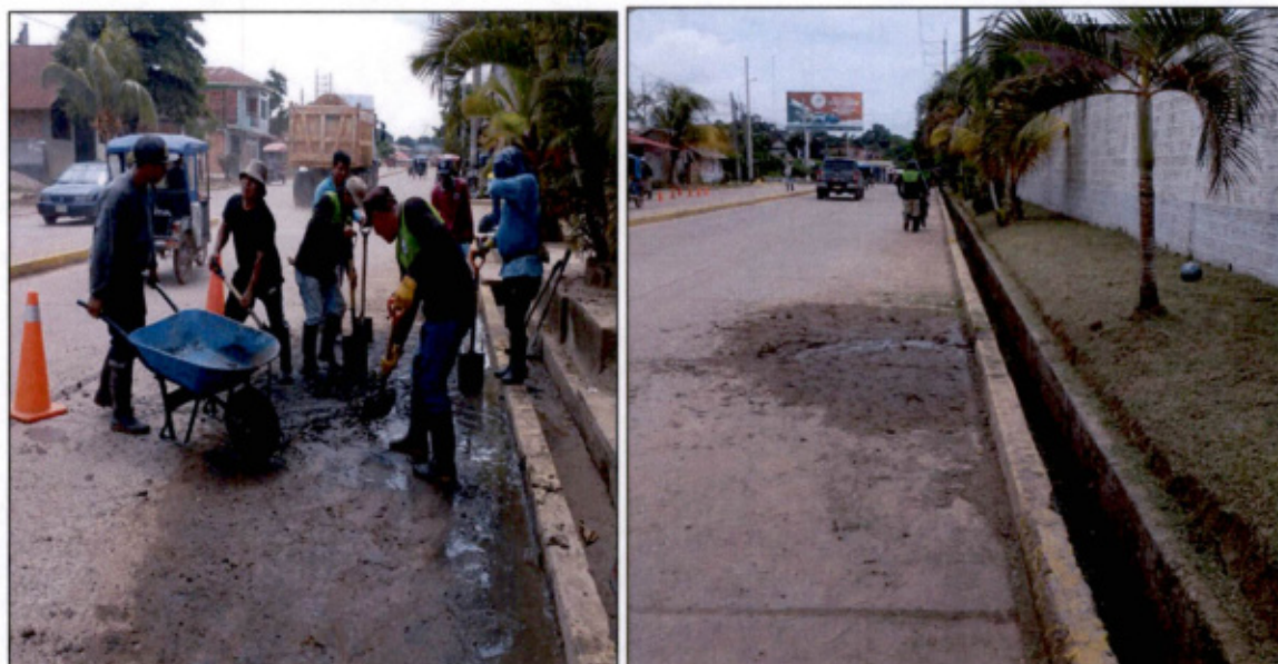
Imagen N 015: Limpieza final con la liberación de residuos en los laterales de las zanjas pluviales
