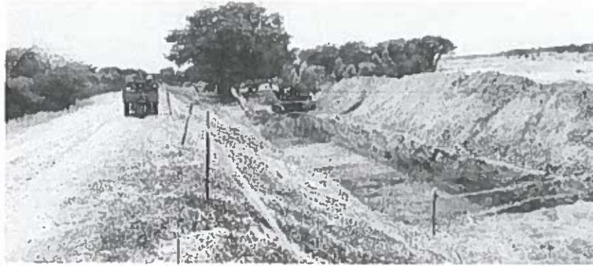
IMAGEN DE TRABAJOS DE EXCAVACIÓN DE UÑA PARA CONFORMACIÓN DE GEOBOLSAS
