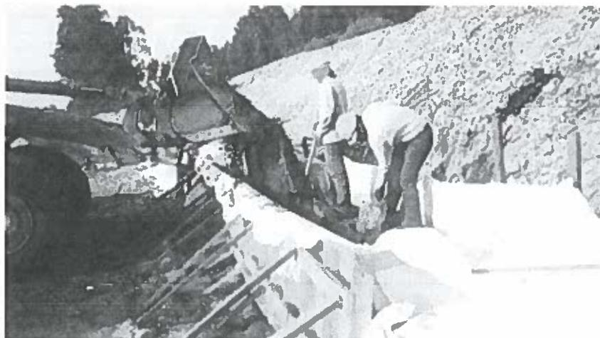
Figura 7 Llenado de la geobolsa con maquinaria pesada
