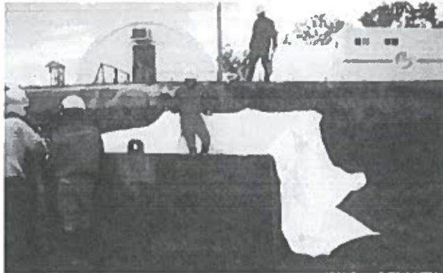
Figura 4 Habilitado de la geobolsa vacía con encofrado metálico
