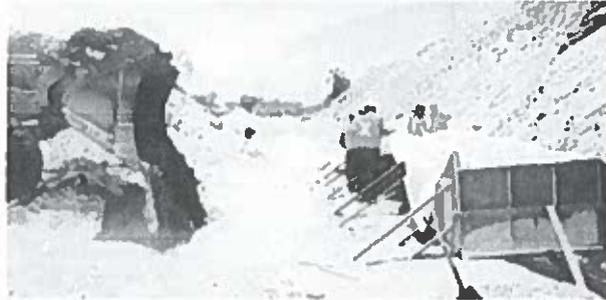
Figura 6 Habilitado de geobolsa vacío con encofrado de madera.
