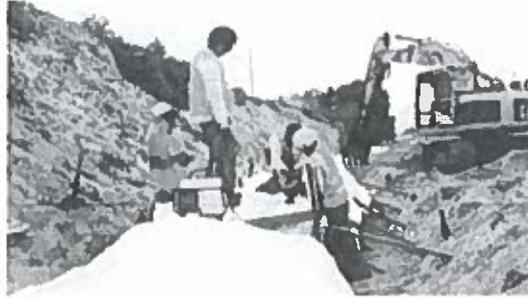
Figura 7 Cierre de la tapa del geocontenedor con cocedora portátil
