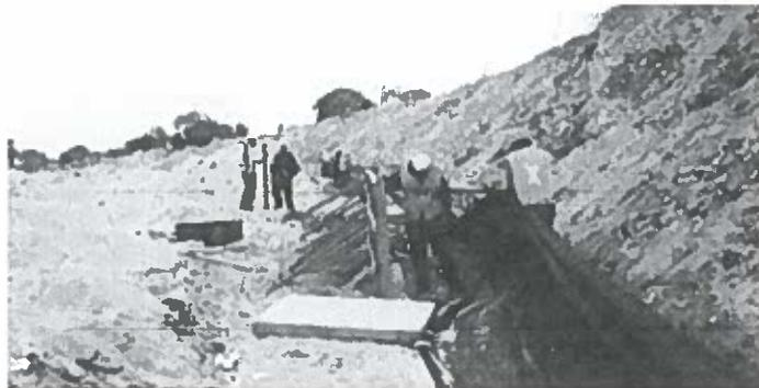
Figura 5 Habilitado de encofrado de madera
