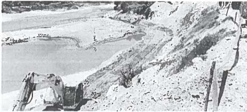
IMAGEN DE TRABAJOS DE RELLENO Y NIVELACION DE TERRENO DE FUNDACION, CON MATERIAL PROPIO
