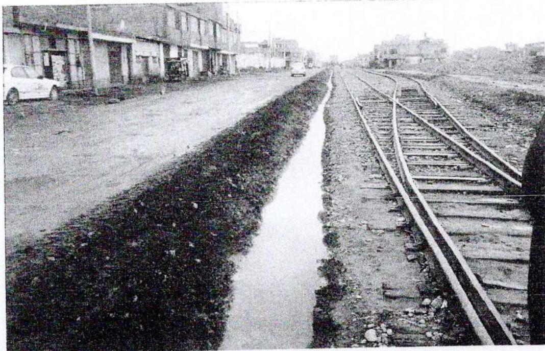
Entubado del sistema de drenaje pluvial (Colapsado) en la última cuadra del Jr. Parra del Riego.
