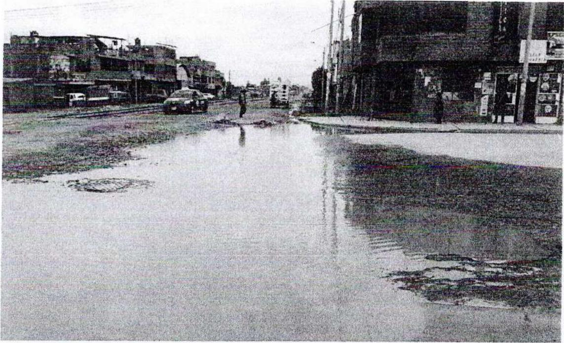
Av. La Esperanza y ferrocarril lugar donde se aniega el agua en temporada de lluvias a consecuencia de la obstrucción del sistema de drenaje fluvial.
