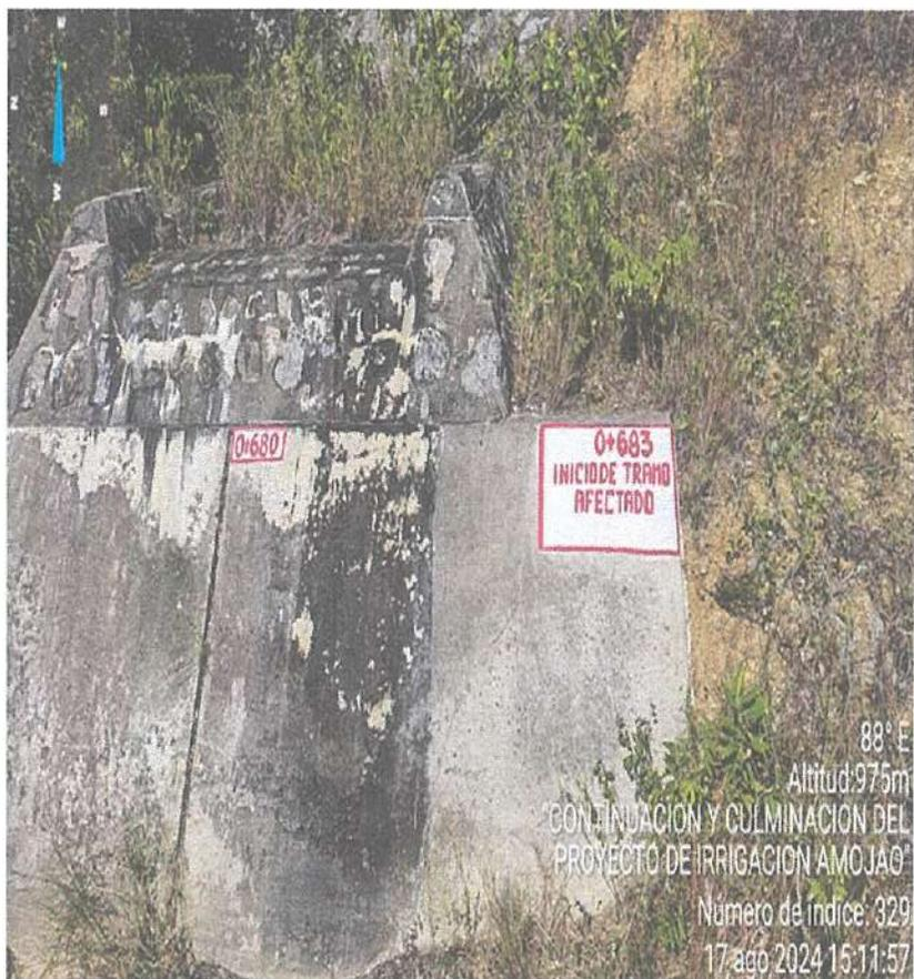
PROGRESIVA 0+683, INICIO DEL TRAMO AFECTADO POR DESLIZAMIENTO DE SUELO
