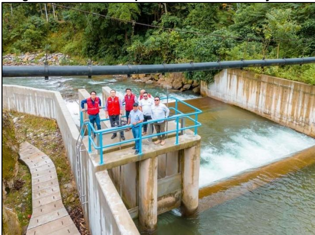
Imagen 8: Visita a la captación en el río Yuracyacu - Moyobamba
