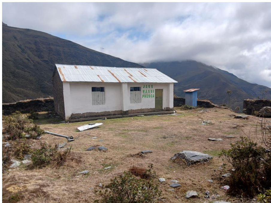
Imagen N° 17: Vista en detalle de local comunal dentro de estructura.
