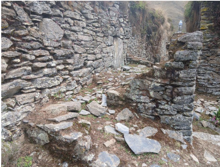
Imagen N° 11: Detalle de posible baño adosado a un acceso de agua.
