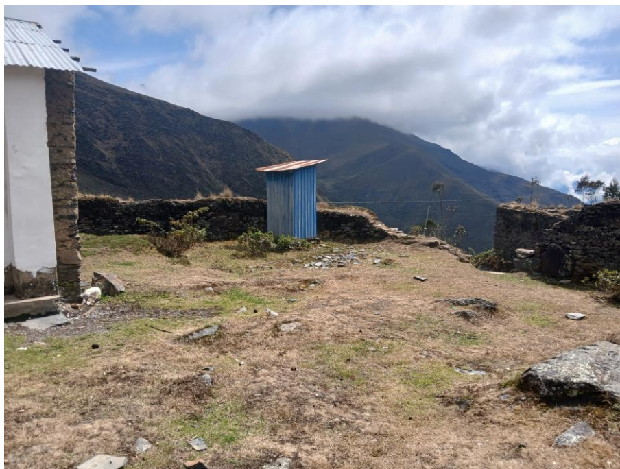
Imagen N° 18: Detalle de letrina al interior del BIP.
