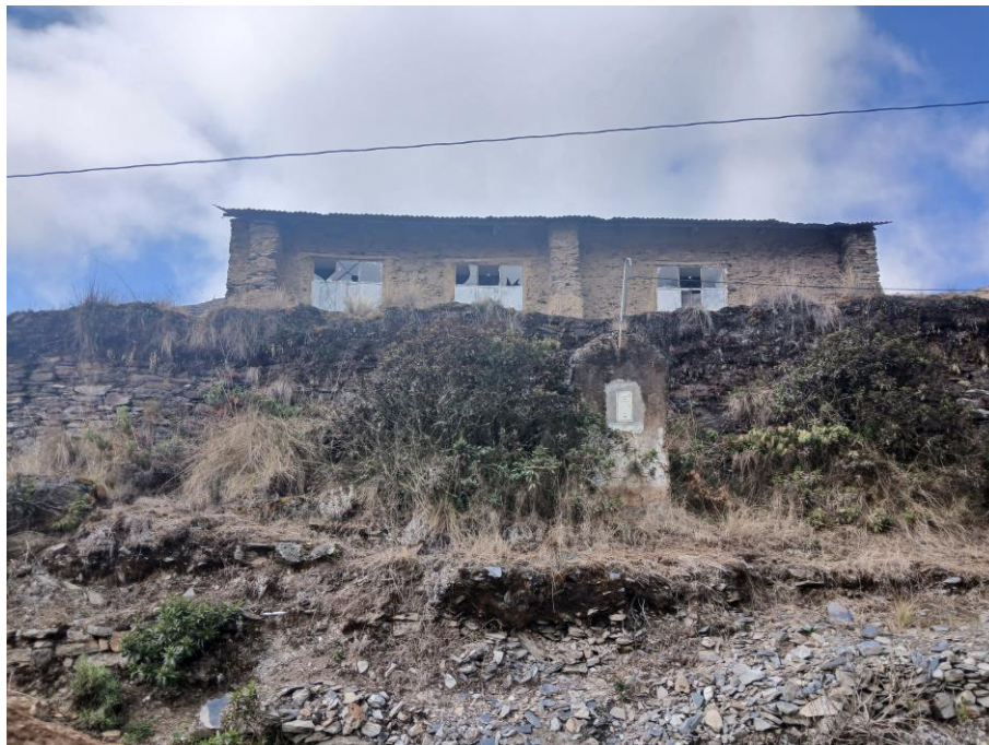
Imagen N° 16: Vista en detalle de local comunal dentro de estructura.
