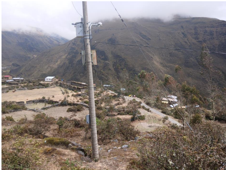
Imagen N° 22: Poste instalado sobre andenería inca.
