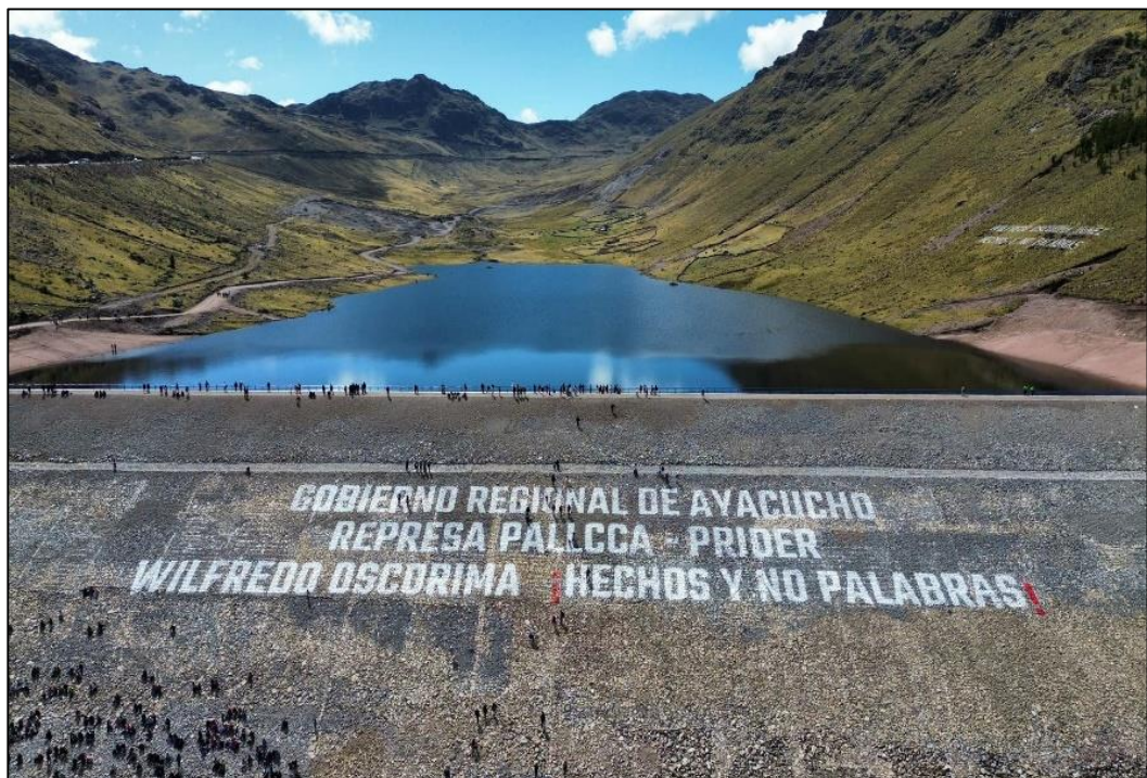
REPRESA PALLCA (CULMINADA Y ENTREGADA EL 30 DE JUNIO DEL 2024).
