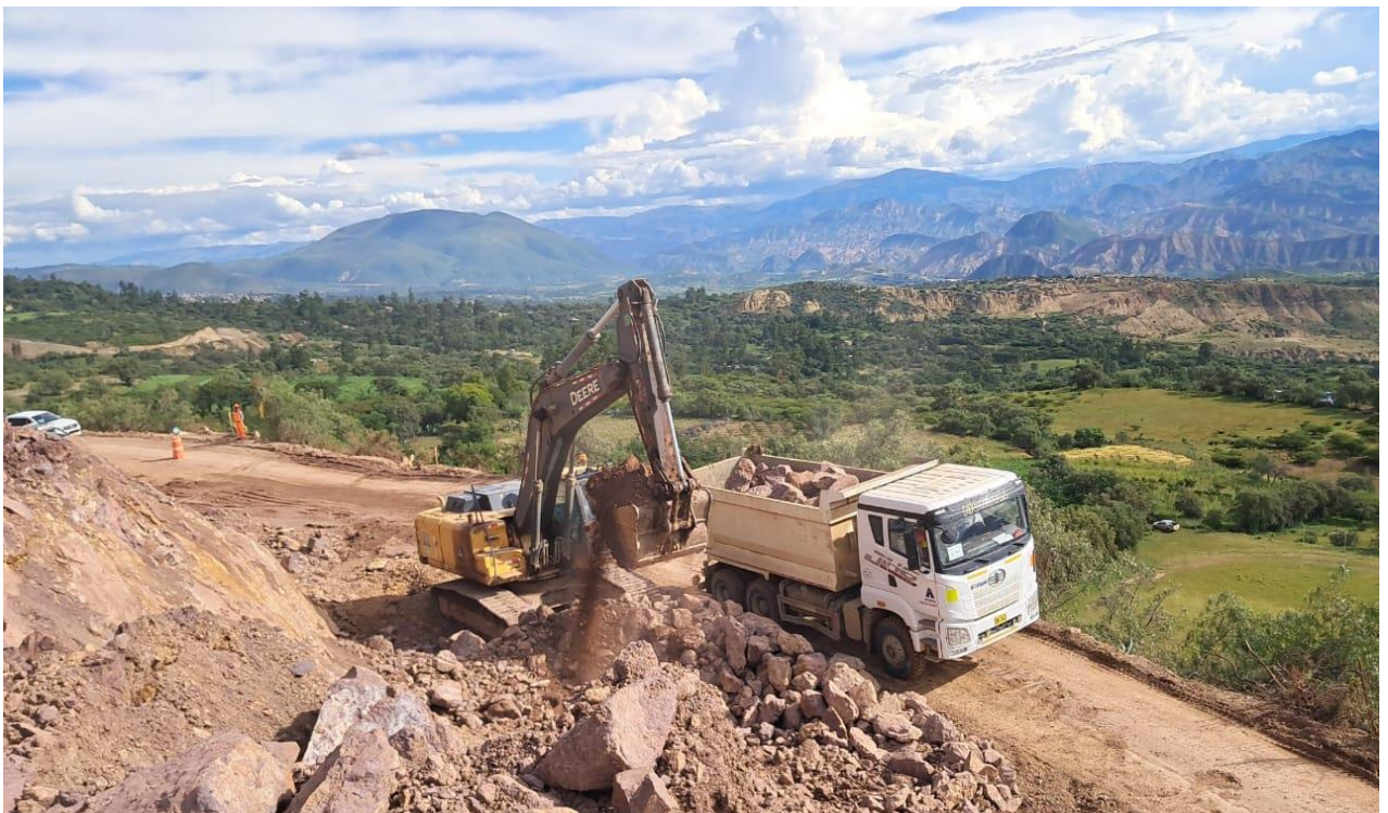
Fotos 05: Cortes, carguío y eliminación de material km. 3+110 al 3+710
