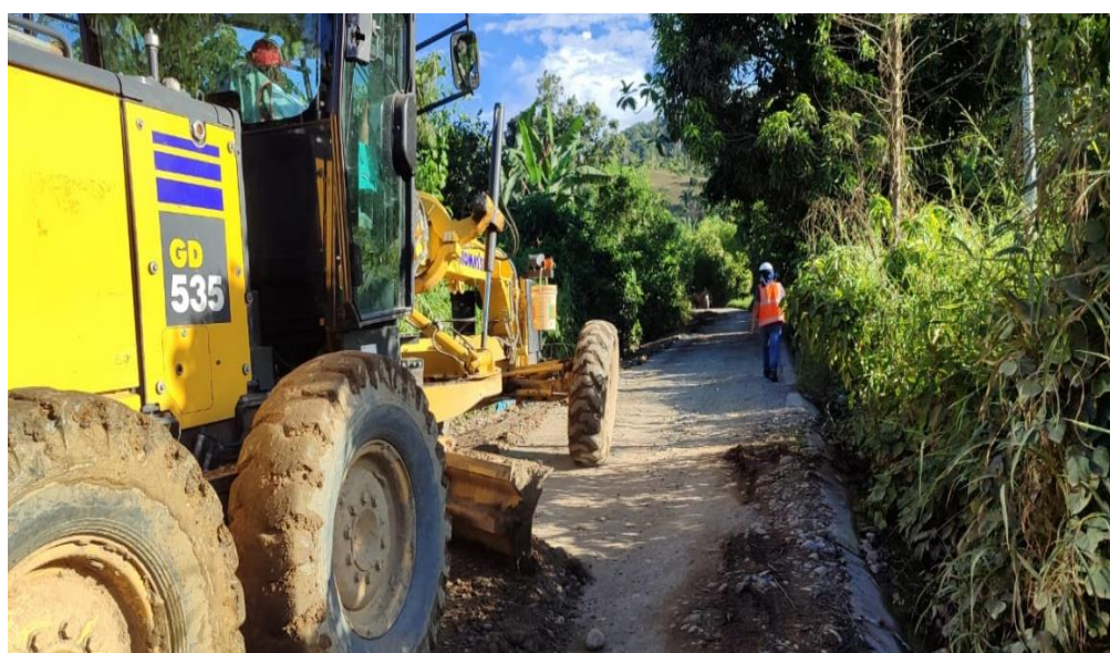
Foto N° 02: Ejecución de actividad de perfilado sin aporte de material y limpieza de cunetas en el tramo de Llochegua hacia puente Acon.
