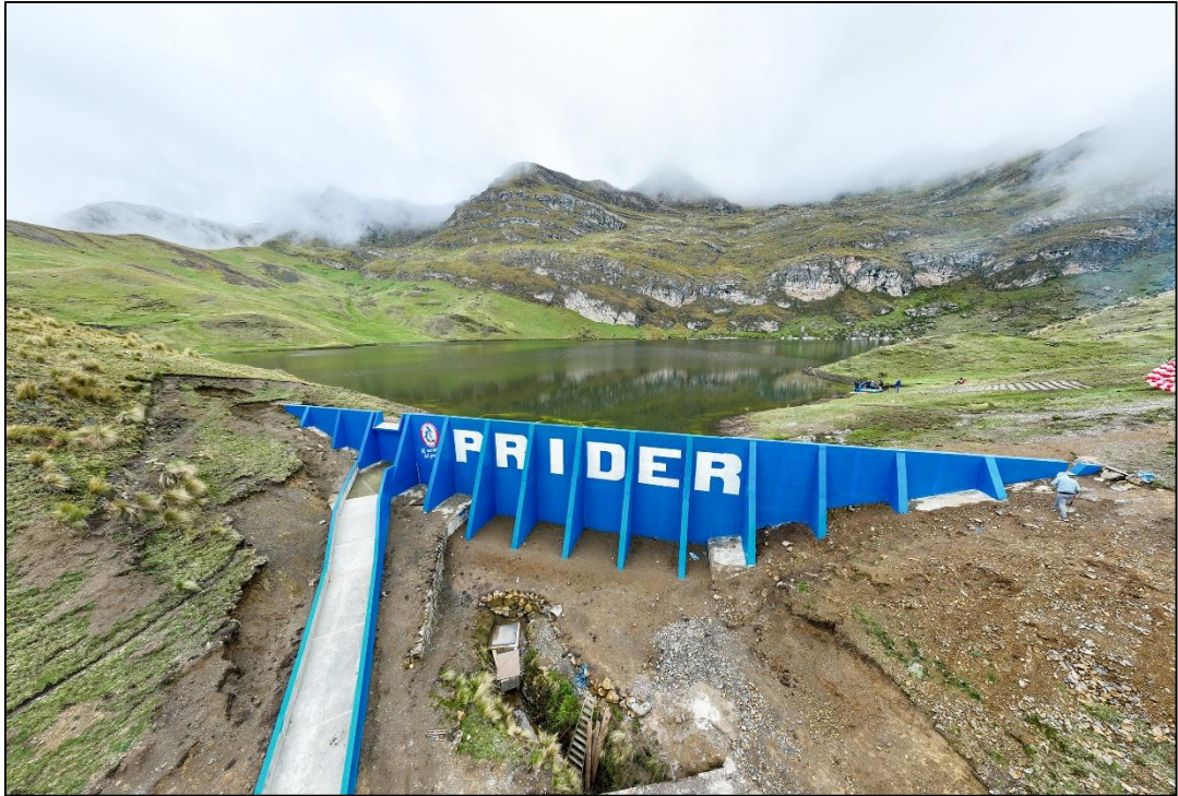
DIQUE ISMUÑAY- YANAQOCHA (CULMINADA Y ENTREGADA EL 15 DE DICIEMBRE DEL 2024).
