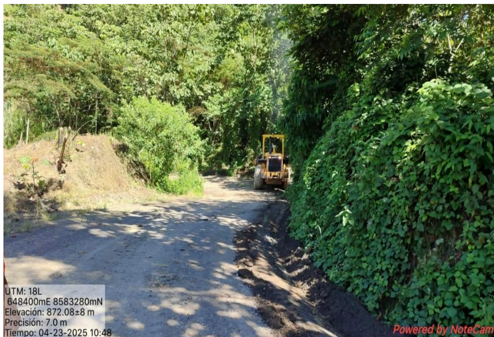
Foto N° 01: Actividad de limpieza de cunetas y perfilado de plataforma sin aporte de material, en la ruta AY-101 en el tramo del centro poblado de Pichiwilca hacia Talanqueato.
