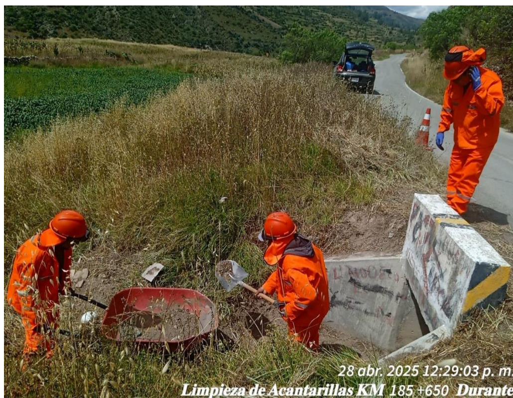
Foto N° 04: Trabajos de limpieza de Alcantarilla en el KM 185+650, en el Tramo Pampacangallo – Huancasancos.
