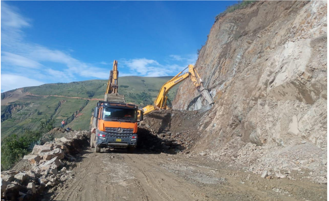
Foto 04 : Cortes, carguío y eliminación de material km. 10+410 al 10+660
