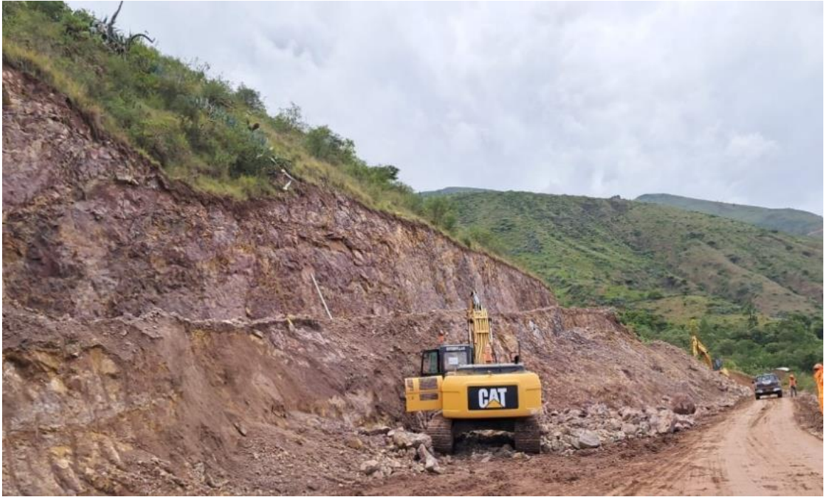
Foto 02: Cortes, carguío y eliminación de material Km. 3+110 al 3+710
