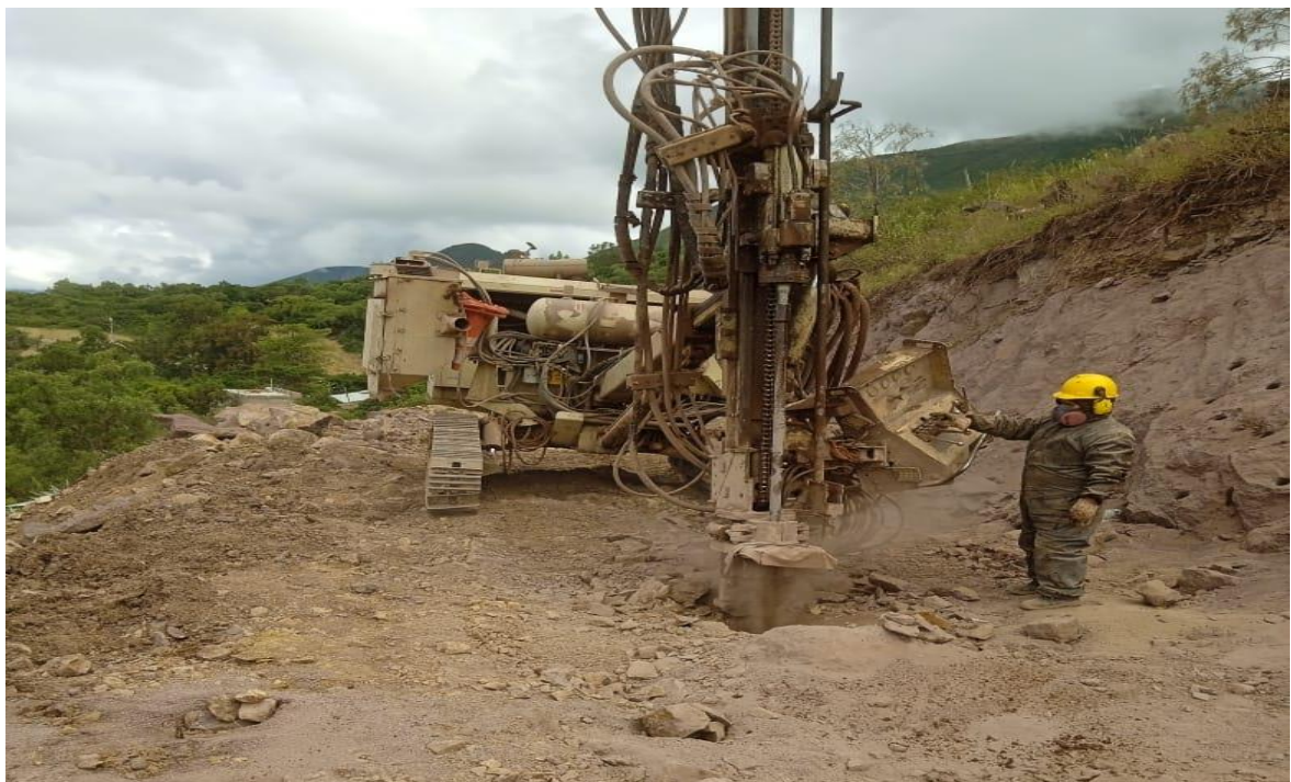
Foto 03: Perforación de sector de roca con rockdrill Km. 3+110 al 3+710
