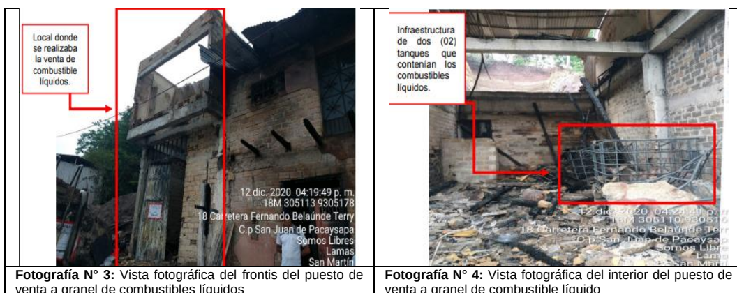
Cuadro N° 4: Local de venta de combustible después de la Emergencia Ambiental
