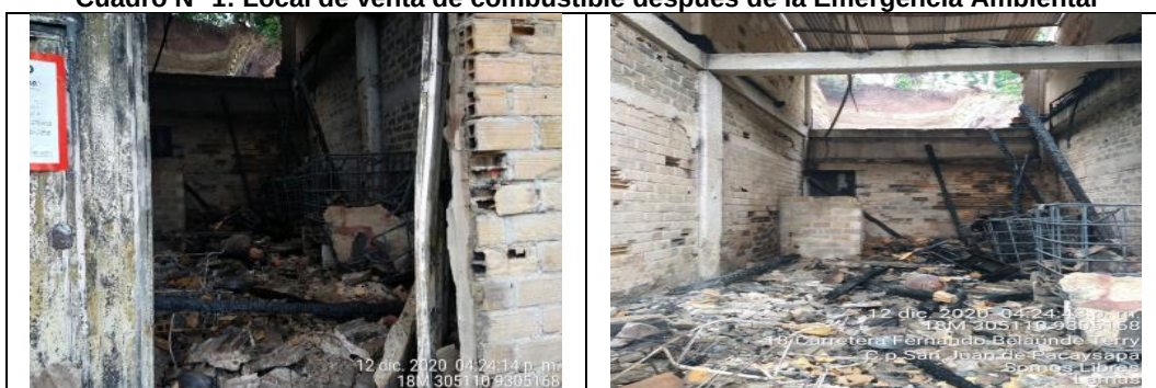
Cuadro N° 1: Local de venta de combustible después de la Emergencia Ambiental
