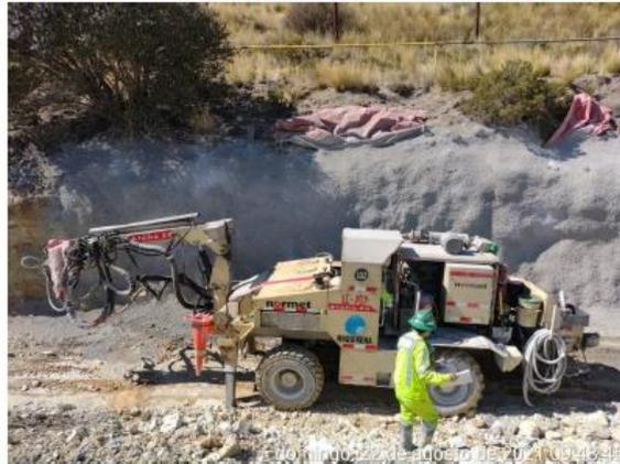
**Figura N° 2:** Culminado de lanzado de shotcrete 3” CF en talud
