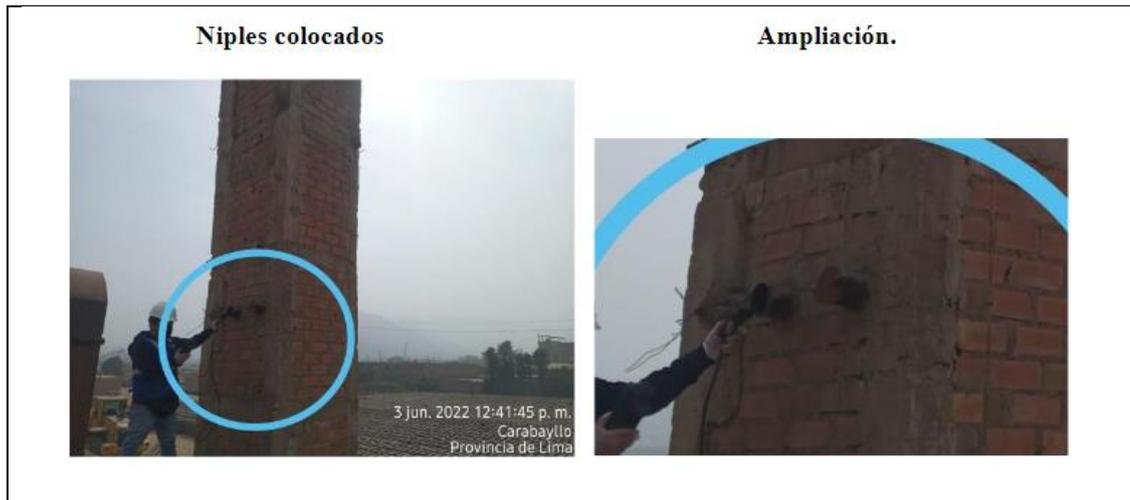
112. Del análisis de dichas imágenes, se advierte que la colocación de los niples (puertos de muestreo) se realizó en una chimenea distinta a la chimenea materia de análisis, siendo dicha chimenea un componente adicional implementado por el administrado de material de concreto diferente a la chimenea rectangular de material metálico.
