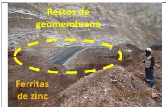
**Fotografía N° 13:** En taludes internos, a lo largo del dique perimetral de la Poza 4-B del Depósito de Escorias y Ferritas Huanchán, se observó restos de geomembrana recortada y/o en mal estado.
