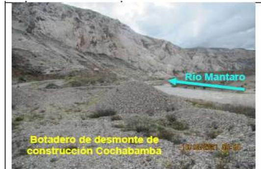
**Fotografía N° 36:** Vista panorámica del Botadero de desmonte de construcción Cochabamba, durante el recorrido se constató que no se ha construido ninguna cuneta de derivación en el perímetro interno.
