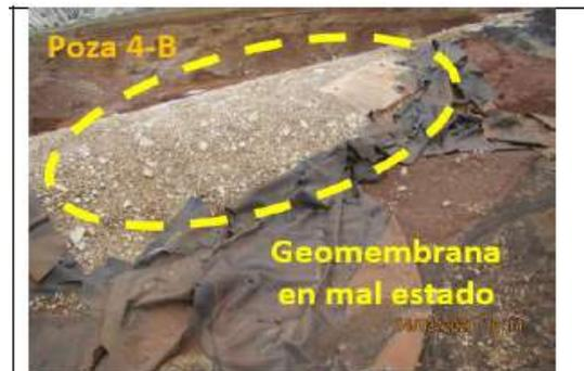
**Fotografía N° 14:** A lo largo del dique perimetral y en varios puntos de anclaje del dique externo de la Poza 4-B, se observó restos de geomembrana recortada y/o en mal estado.
