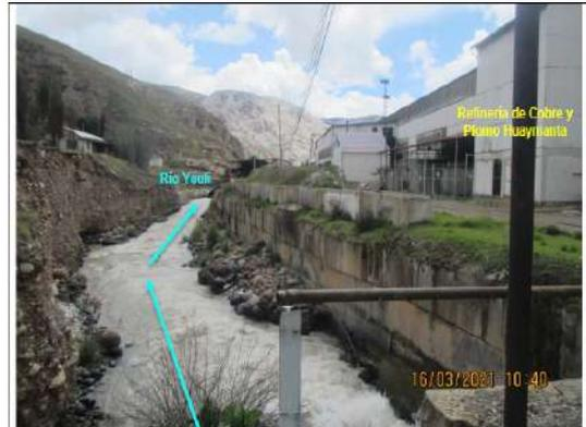
Fotografía N° 33: Se realizó el recorrido del perímetro de la la Refinería de Cobre y Plomo Huaymanta, en la vista del margen izquierdo del Río Yauli, se observa que no se había construido canales de interceptación de escorrentía superficial al pie del talud de los cerros ubicados a la margen izquierda del Río Yauli.
