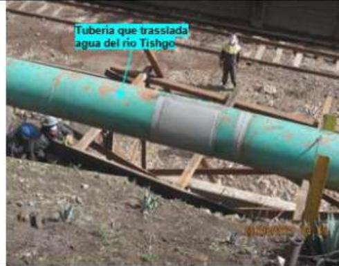
Fotografía N° 138: Tubería reparada de traslada agua del río Tishgo.
