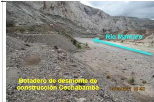
**Fotografía N° 37:** Vista del talud del Botadero de desmonte de construcción Cochabamba hacia el Río mantaro, se constató que no se ha construido el enrocado para contrarrestar los efectos erosivos del río Mantaro.
