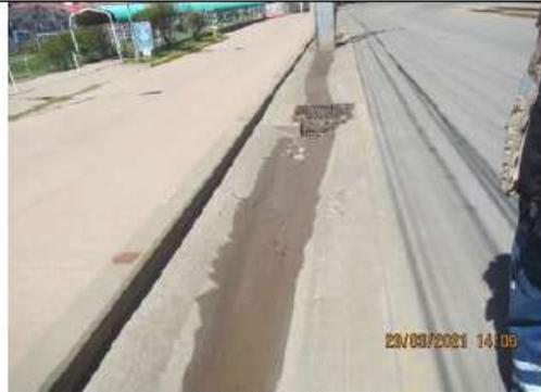
Fotografía N° 144: Cunetas del área adyacente por donde habría discurrido el agua proveniente de la ruptura de la Tubería, con presencia de sedimentos.
