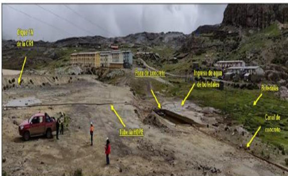
Fotografía N° 134. Vista panorámica de la poza de concreto ubicada aproximadamente a 75 metros al noroeste del Dique 1A de la CR1. El agua de la poza de concreto sería derivada mediante una tubería y bombas de HDPE hacia la superficie de la CR2.<sup>134</sup>
