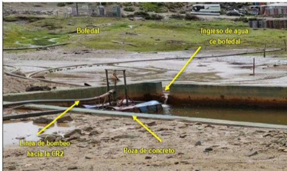
Fotografía N° 131. Vista del ingreso de agua de no contacto del bofedal hacia la poza de concreto. Se observa que el agua es acumulada al interior de la poza, la misma que cuenta con una bomba y una línea de tubería de HDPE.<sup>130</sup>
