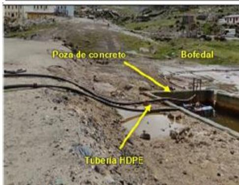
Fotografía N° 132. Se observa tubería HDPE conectada a un sistema de bombeo instalada dentro de la poza.<sup>132</sup>
