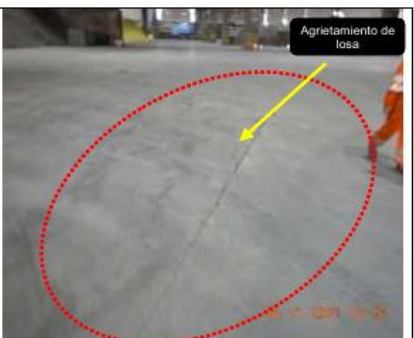
Fotografía N° 14. Vista fotográfica de la fisura ubicada en el área 8 del almacén de zinc y cobre, en la coordenada WGS 84 zona 18: 8667929N, 268218E 42 .
