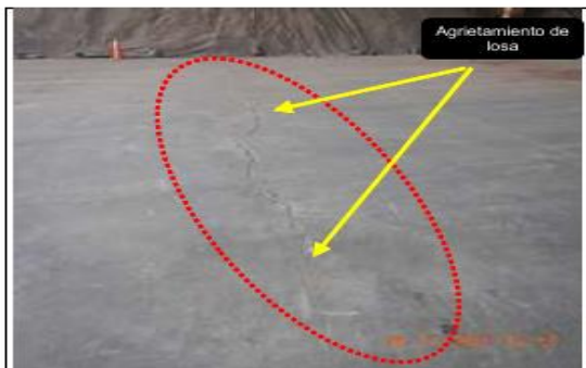
Fotografía N° 6. Vista fotográfica de la fisura ubicada en el área 4 del almacén de zinc y cobre, en la coordenada WGS 84 zona 18: 8667931N, 268284E 34 .
