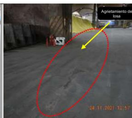
Fotografía N° 20. Vista fotográfica de la fisura ubicada en el área 11 del almacén de zinc y cobre, en la coordenada WGS 84 zona 18: 8667922N, 268182E 48 .
