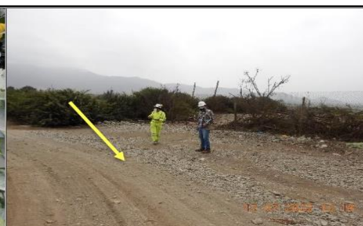
Fotografía N° 23. Ubicación en campo del punto de monitoreo E-2 con coordenadas UTM - WGS 8 729 372.111N 251 845.220E (Coordenadas aprobadas en la MEIAD-2018) 60
