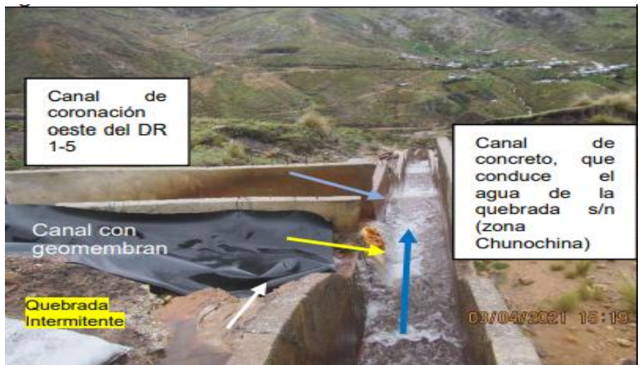
Fotografía N° 16 51 Vista donde se observa la descarga del agua de contacto del canal revestido con geomembrana sobre el canal de concreto, así como, la descarga de agua de no contacto del canal de concreto, ambos en el canal de concreto que conduce el agua de la quebrada s/n (zona Chunochina).
