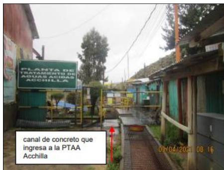
Fotografía N° 531 Vista donde se observa parte del recorrido del canal de concreto que conduce el agua ácida de la bocamina principal Acchilla Nv. 420, y que ingresa a la PTAA Acchilla
