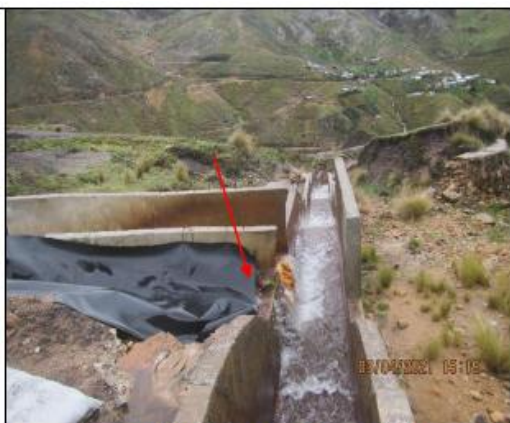
Fotografía N° 64 180 : Vista donde se observa la descarga del agua de contacto del canal revestido con geomembrana sobre el canal de concreto, así como, la descarga de agua de no contacto del canal de concreto, ambos en el canal de concreto que conduce el agua de la quebrada s/n (zona Chunochina).
