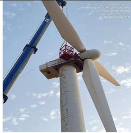
Fotografía del 26 de marzo de 2022. Se observa el uso de una grúa cerca del generador para elevar una cesta suspendida, dentro del cual se observan operarios.
