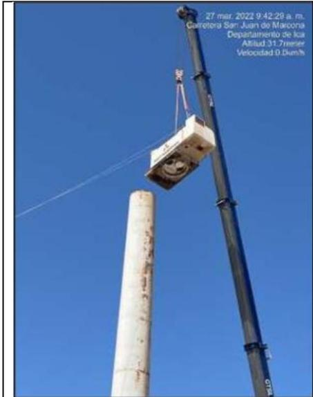
Fotografía del 27 de marzo de 2022. Se observan trabajos de desmontaje de un componente del aerogenerador.
