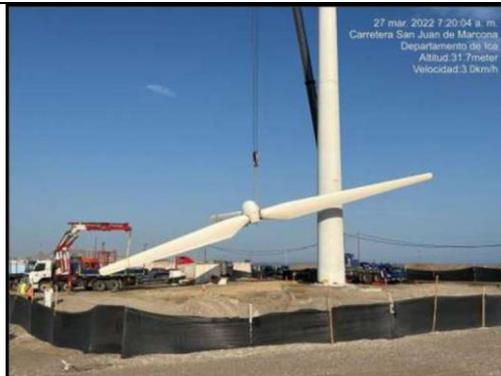
Fotografías del 27 de marzo de 2022. Se observan trabajos desmontaje del aspa aerogenerador.
