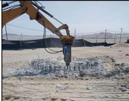
Fotografía sin fecha, se observa la demolición de la base de concreto del aerogenerador.
