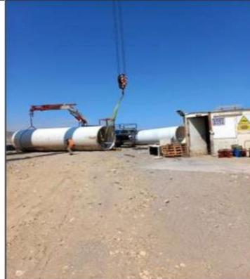
Fotografías sin fecha, estas corresponderían a las actividades de desmontaje de la torre del aerogenerador.
