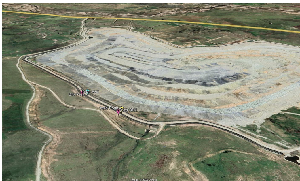
Figura n.º 3: Ubicación de las pozas adyacente al componente minero Botadero Norte
