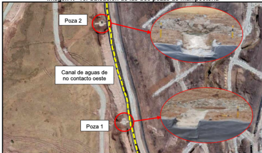
Imagen N° 13. Ubicación de las dos pozas de mampostería
