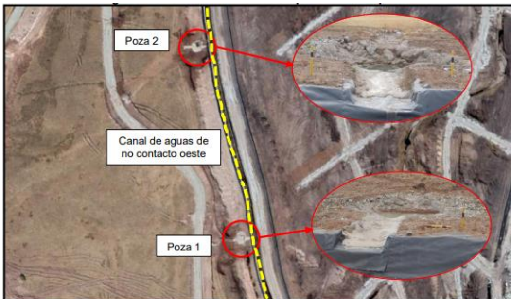
Figura n.º 2: Ubicación de las dos pozas de mampostería
