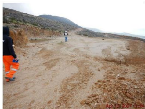
Fotografía N° 151: Vista del área correspondiente a la plataforma P109, se observa corte del terreno, área disturbada y erosión hídrica. (Fotografía DSCN7347)
