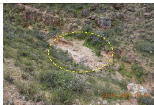
Fotografía N° 236: Otra vista del lecho de la quebrada sin nombre donde se observa material arrastrado proveniente del proyecto. (Fotografía DSCN8235)
