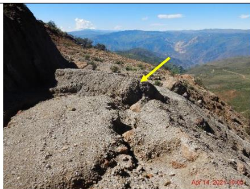
Fotografía N° 180: Vista de la erosión hídrica presente en el área de la plataforma sin nombre N° 1. (Fotografía DSCN7664)
