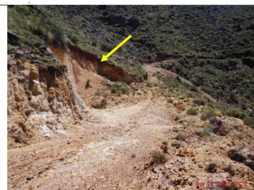
Fotografía N° 181: Vista del área de la plataforma sin nombre N° 2, se observa el corte del terreno y un relleno parcial del área de la plataforma. (Fotografía DSCN7701)
