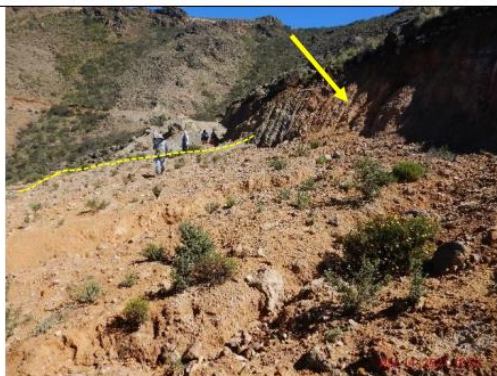
Fotografía N° 179: Vista de la Plataforma sin nombre N° 1, se observa el corte del terreno y un relleno parcial del área de la plataforma. (Fotografía DSCN7667)
