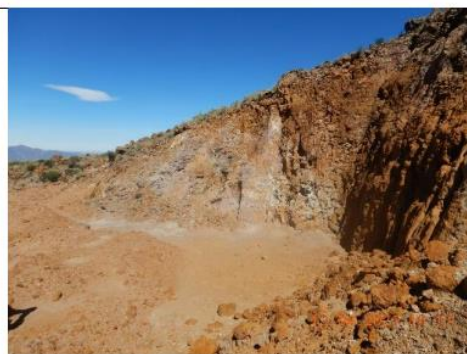
Fotografía N° 150: Vista del área correspondiente a la plataforma P105, se observa corte, área disturbada y relleno parcial. (Fotografía DSCN0535)
