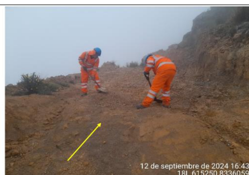
Fotografía 2: Vista de los trabajos de cierre del sondaje en la plataforma P112, se observa el llenado del pozo con material de corte de perforación por debajo del nivel de la tierra.
