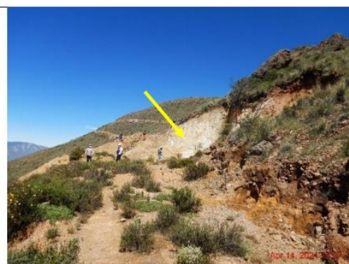
Fotografía N° 182: Vista panorámica de la plataforma sin nombre N° 2, en la cual se observa el corte del terreno y material dispuesto sobre el área de la plataforma. (Fotografía DSCN7709)
