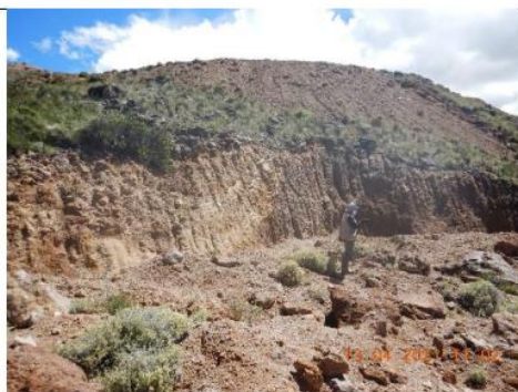
Fotografía N° 149: Vista del área correspondiente a la plataforma P79, se observa corte, área disturbada y relleno parcial. (Fotografía DSCN0604)
