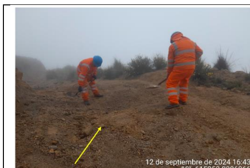
Fotografía 1: Vista de los trabajos de cierre del sondaje en la plataforma P112, se observa el llenado del pozo con material de corte.
