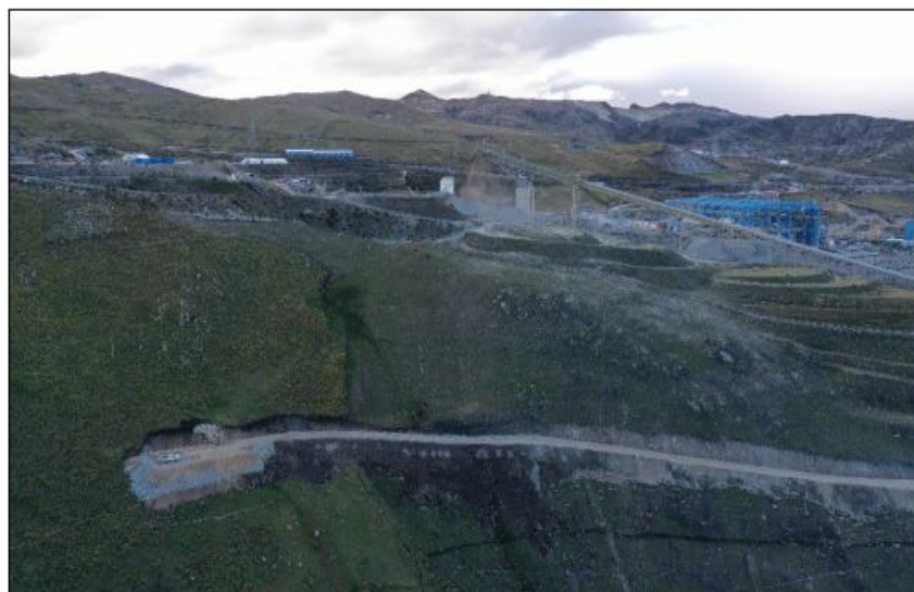
Figura N° 6: Vista aérea del canal y la pila de mineral
