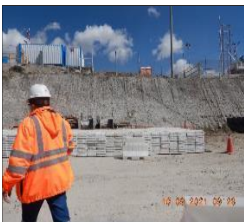
Fotografía N° 118 (DSCN4798.JPG): Vista del almacenamiento de testigos dentro de cajas sobre parihuela en el área CC Lay Down.
