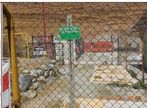
Fotografía N° 151 (DSCN6381.JPG): Vista de las pozas soterradas para aguas ácidas, donde estaba instalado un medidor de agua de la poza ácida.
