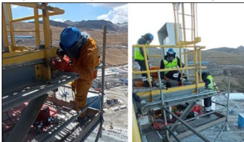
Figura n.º 15: Trabajos realizados conforme cronograma
