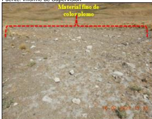
Fotografía N° 78: Vista de otro punto en donde se observó el material fino de color plomo sobre el suelo contiguo al DME y DMO. Se observa escasa vegetación.
