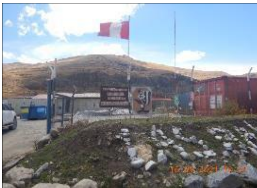
Fotografía N° 142 (DSCN6356.JPG): Vista del ingreso a la plataforma donde se construyó un laboratorio para el tratamiento de muestras de testigos.
