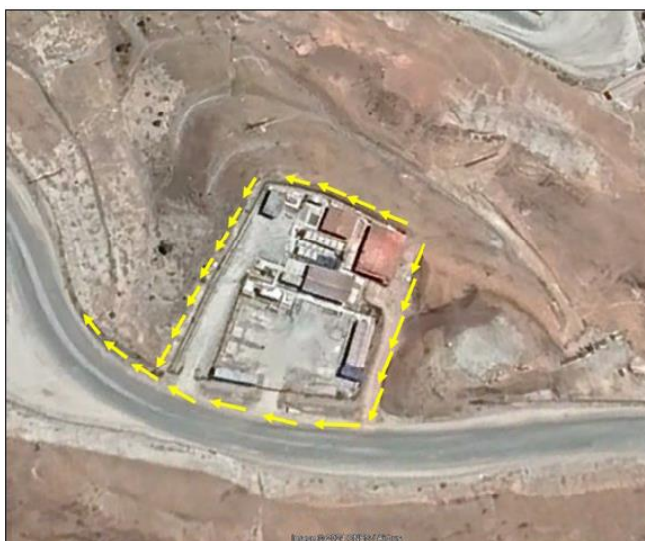
Figura N° 18 Se observa el manejo del drenaje superficial
