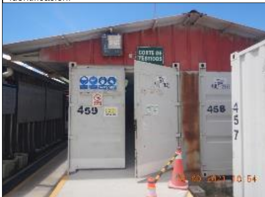
Fotografía N° 146 (DSCN6366.JPG): Vista de la sala de cortes de testigo, construido con estructura metálica.
