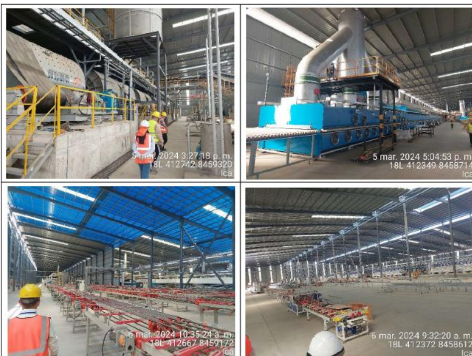
Imagen N° 01, N° 02, N° 03 y N° 04: En las imágenes se observa algunas de las diferentes áreas ya implementadas en la Planta Industrial.
