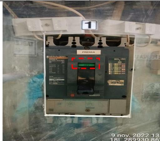
**Fotografía N° 5:** Se observa que los tableros de control que alimentan de corriente a los equipos y máquinas se encuentran apagados (OFF) - fotografía con código TimePhoto\_20221109\_130029.
