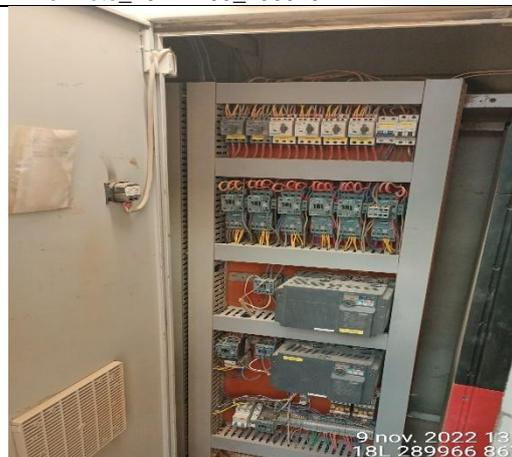
**Fotografía N° 7:** Se observa el tablero de control del área de molienda con las llaves apagadas (fotografía con código TimePhoto\_20221109\_130250).
