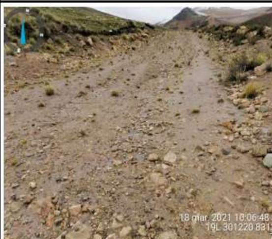
Fotografía 51. Corresponde al archivo TimePhoto_20210318_100648.jpg, donde se puede observar el acceso inoperativo al área disturbada.
