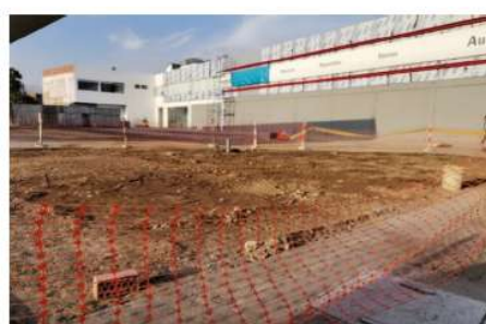
Se procedió al humedecimiento de la zona de trabajo con agua.
