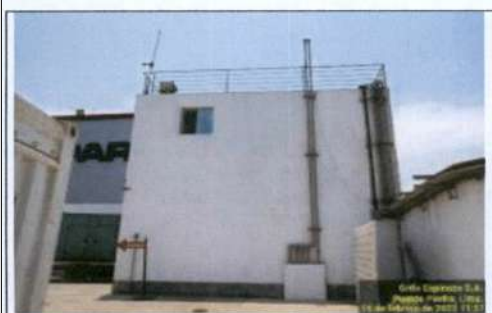
Fotografía N° 15: Infraestructura de concreto de dos (2) pisos y tubería de venteo.
