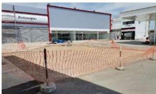
Malla de seguridad para delimitar área de trabajo, evitando intrusiones de terceros
