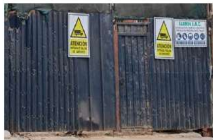
Señalizaciones de seguridad sobre portón metálico que delimita zona de trabajo.
