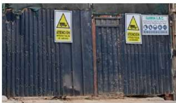
Señalizaciones de seguridad sobre portón metálico que delimita zona de trabajo.
