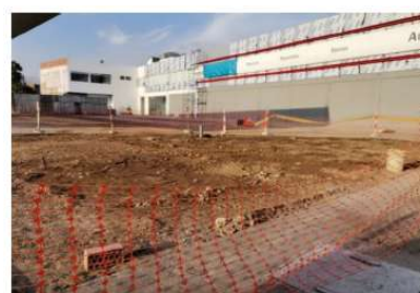
Se procedió al humedecimiento de la zona de trabajo con agua.
